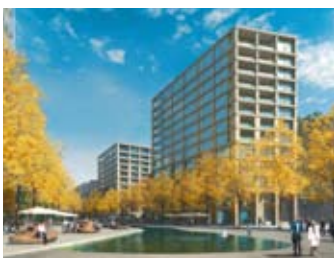
In Zürich entsteht auf insgesamt 78 000 m 2 das neue Quartier Euro-palée (Bild: SBB).
