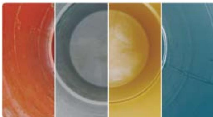
Die vier Phasen der Sanierung einwandiger erdverlegter Tanks von links nach rechts: Gereinigt, sandgestrahlt, beschichtet, mit Kunststoffolie ausgekleidet
