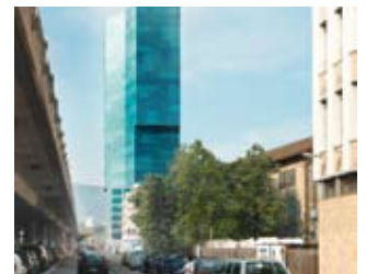
Eines der Projekte der Karl Steiner AG: der Prime Tower in Zürich.
