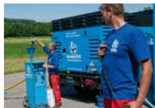
Die Rohranalyse (links oben) schafft die Entscheidungsgrundlage für das weitere Vorgehen. Bei der Rohrrinnensanierung müssen Leitungen nicht ersetzt werden, sondern lassen sich über ein umweltfreundliches Verfahren reinigen (links unten) und mit Kunststoff beschichten (rechts). Die Betriebsunterbrüche sind dabei minimal.
