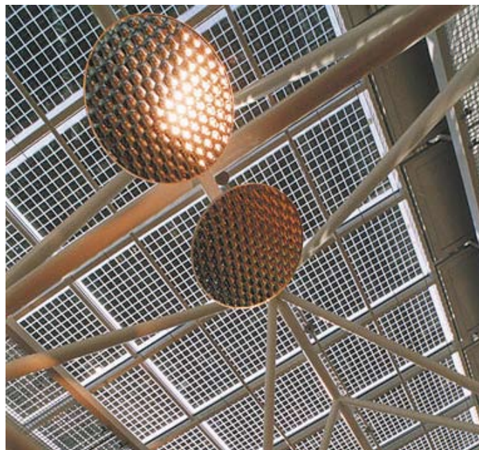
Synergien nutzen und Kosten sparen: Solarzellen dienen auch als Beschattungselemente.
