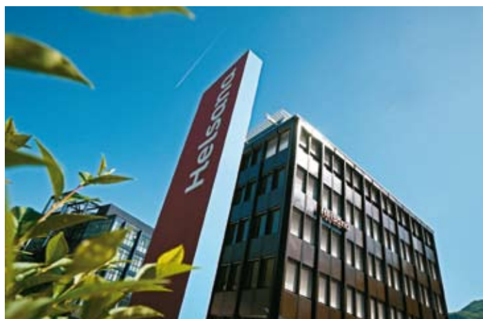
Das einprägsame Gebäude der Helsana an der Piazza del Sole in Bellinzona, am Fusse des Burghügels Castelgrande.
