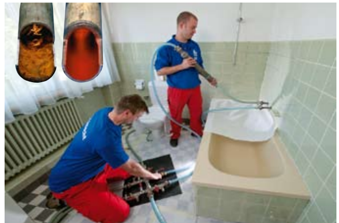
Die Rohranalyse (links oben) schafft die Entscheidungsgrundlage für das weitere Vorgehen. Bei der Rohrrinnensanierung müssen Leitungen nicht ersetzt werden, sondern lassen sich über ein umweltfreundliches Verfahren reinigen (links unten) und mit Kunststoff beschichten (rechts). Die Betriebsunterbrüche sind dabei minimal.
