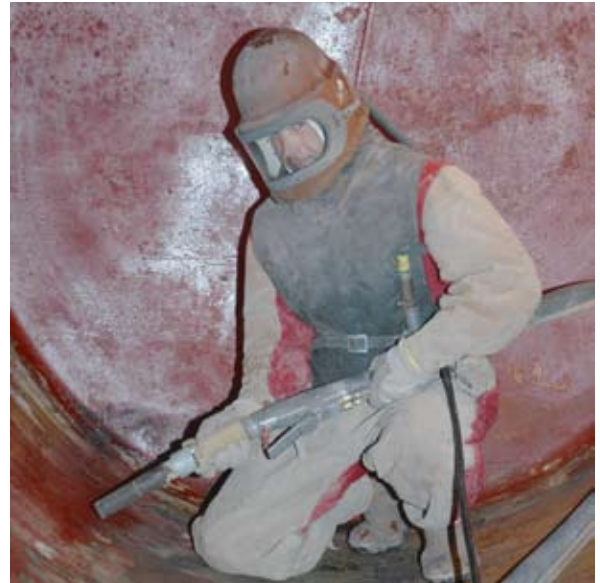
Sandstrahlen des Stahltanks, vor der Beschichtung
