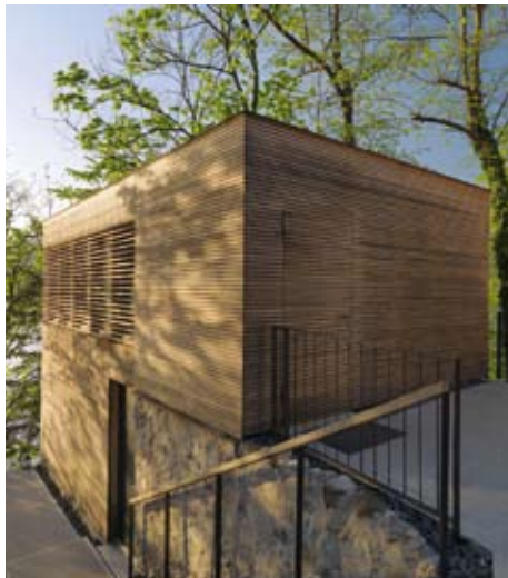
Der Pavillon mit Eichenholz-Lamellenverkleidung – neu erstellt auf historischen Mauern.
