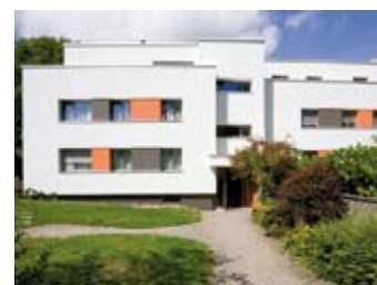
nach der Sanierung: Ästhetik und Energieeffizienz vereint.
