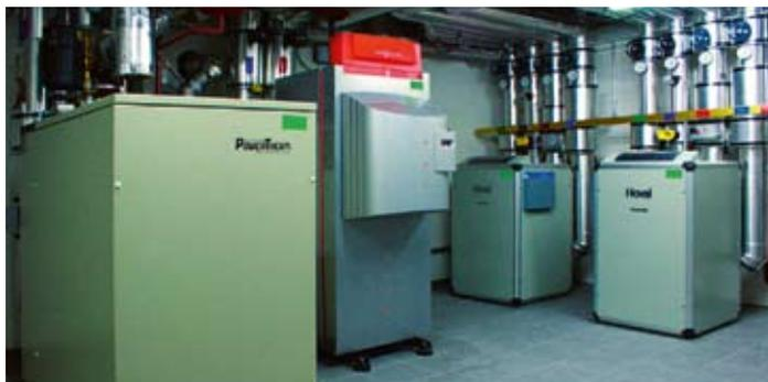
Von links nach rechts: Das Gasmotor-Blockheizkraftwerk, der Gas-Kondensationskessel und die beiden Erdsonden-Wärmepumpen. Unten die Speicher für Labor-Warmwasser, BHKW und Wärmepumpen
