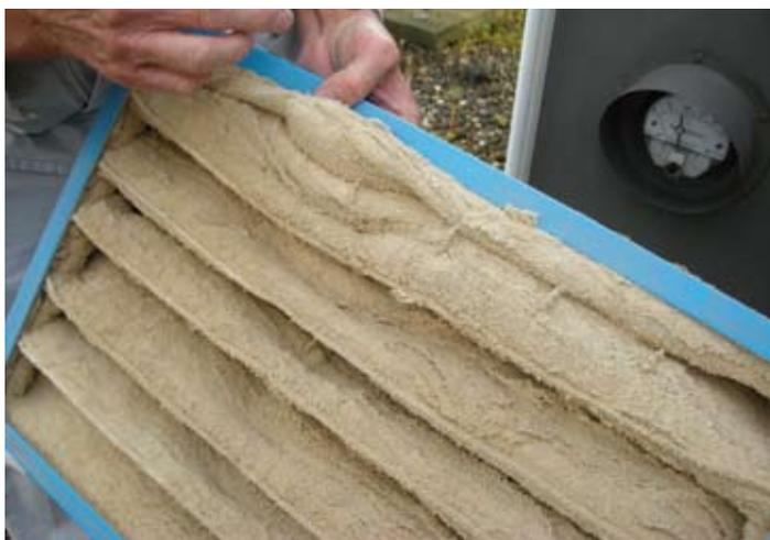
Bild 2: Verschmutzung eines SynaWave® Filters auf der Anlage 2 nach drei Monaten Einsatz. Die Filter wurden nach neun Monaten ausgetauscht. Früher alle zwei Monate.
