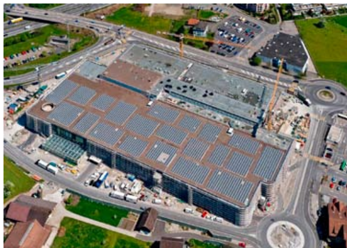
Das grösste Solarkraftwerk der Zentralschweiz steht auf einem Minergie-zertifizierten Einkaufszentrum.
