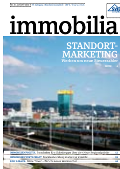
Prime Tower – Zürichs neues Wahrzeichen (Bild: Ivo Cathomen).
