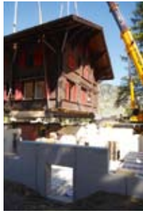
Mit Pneukranen wird das Chalet auf das neue Fundament gehoben.
