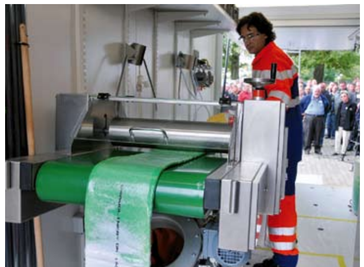
Höhepunkt war die Live-Vorführung einer Schlauchliner-Kanalsanierung, dem jüngsten Tätigkeitsgebiet des über 50-jährigen Familienunternehmens. Im Bild wird der nahtlose Textilschlauches Brawoliner® mit Epoxidharz getränkt.
