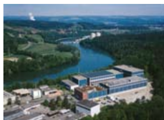
Das zentrale Zwischenlager in Würenlingen.
