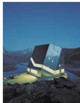
Minergie-A geht weiter als die bisherigen Standards (Bild: Monte Rosa-Hütte / Minergie-P).
