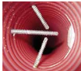
Leider kommt es im Bereich der Wohnungslüftung zu oft vor, dass Lüftungsrohre vor dem einbetonieren unsachgemäss installiert wurden. Eine richtige Reinigung wird somit verunmöglicht.
