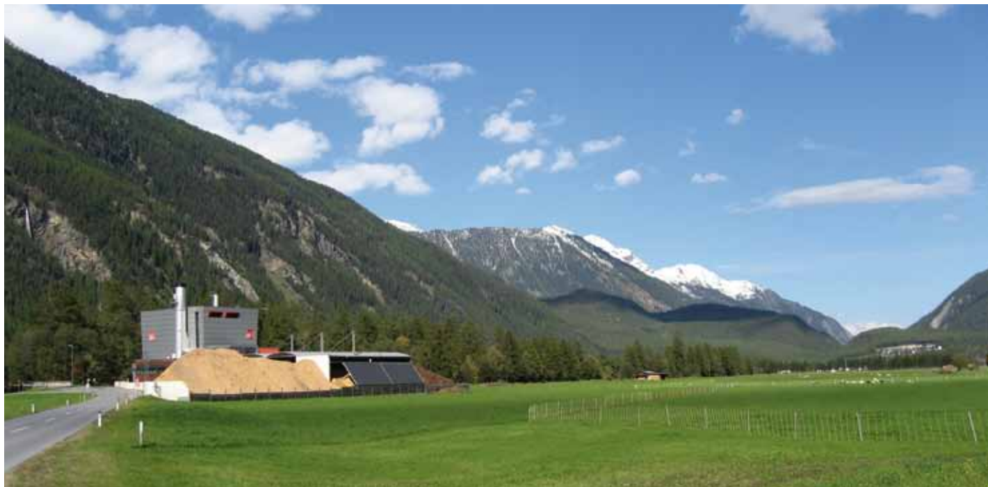
Das Biomasse-Heizkraftwerk Längenfeld im Oetzal versorgt 200 Haushalte mit einem 15 km langem Fernwärmenetz (Fotos: Polytechnik Biomass Energy).
