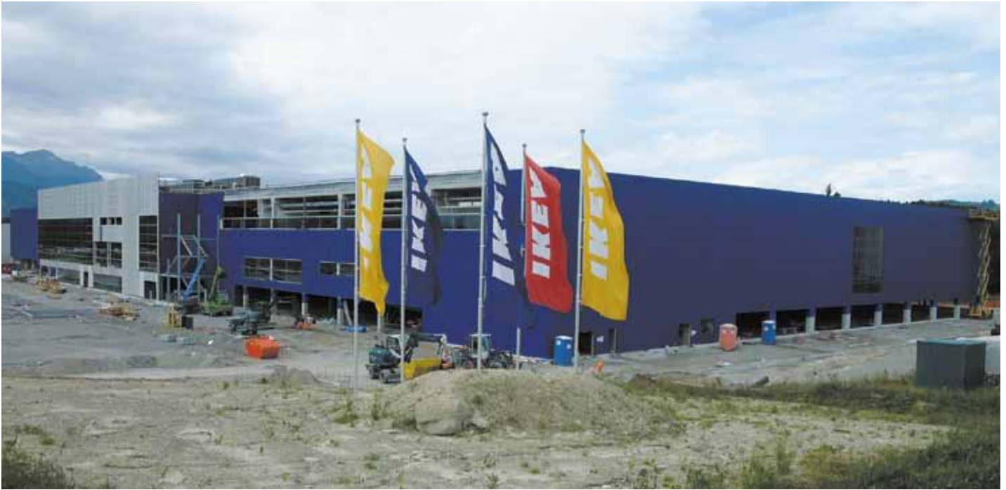
Die Bauarbeiten am neuen IKEA-Standort Rothenburg schreiten voran – Stand 9. August 2011.
