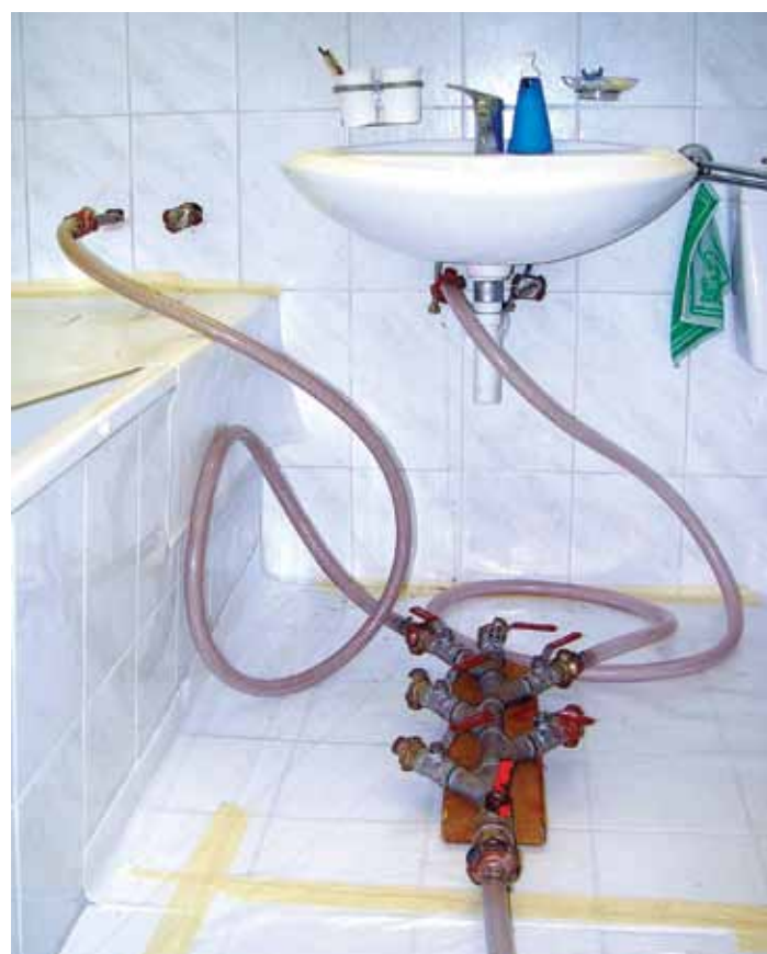
Nach der Rohrreinigung erfolgt die Innenbeschichtung der Wasserleitungen.
