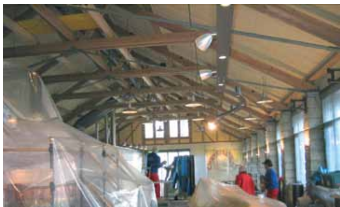
Sanierung eines Restaurants in einem alten Tramdepot. Reinigung des Dachstuhles.
