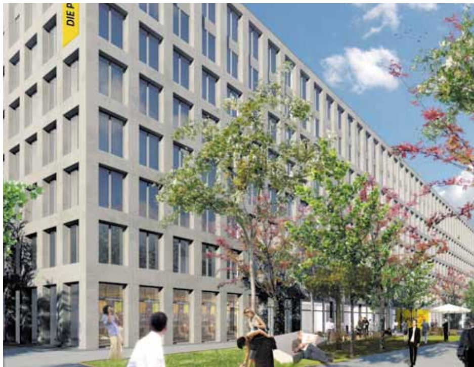
Das Majowa beim Stade de Suisse in Bern ist ein Paradebeispiel für gelungenes baubegleitendes Facility Management. Mibag unterstützt die Bauherrschaft hier unter anderem beim Erreichen des Nachhaltigkeitslabels DGNB/SGNI Gold.
