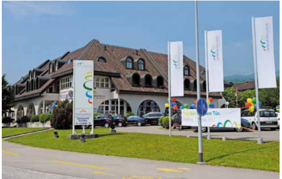
Das neue Ausbildungszentrum Reinigung in Rickenbach SO (Bild: Allpura).
