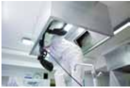
Die Reinigung von Filteranlagen erfordert Spezialkenntnis – hier im Bereich des Abzugs.
