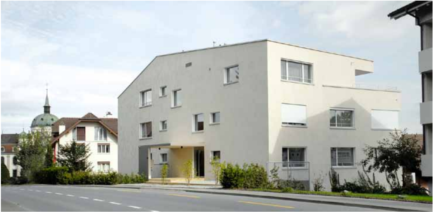
Ein gelungenes Beispiel für ein Mehrfamilienhaus mit Einfamilienhausqualitäten von GKS Architekten + Partner AG in Eschenbach LU (Bild: GKS).
