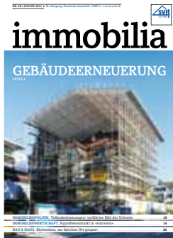
Titelbild: Gebäudeerneuerung in Rüschlikon ZH (Bild: Ferit Kuyas).
