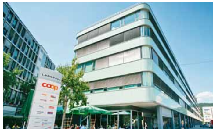
Das Langhaus in Baden, ein markanter Bau des Badener Bahnhofsgebietes.
