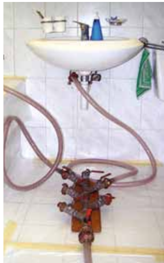
Nach der Rohrreinigung erfolgt die Innenbeschichtung der Wasserleitungen.
