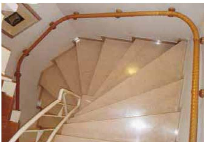
Nachgerüstet mit einem wandseitigen Handlauf, wo die Stufen breiter und sicherer sind. Bild: Flexo-Handlauf
