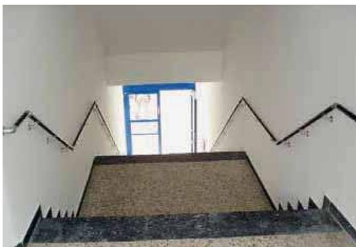
Nachgerüstet mit beidseitigen Handläufen im Öffentlich zugänglichen Gebäuden. Bild: Suva
