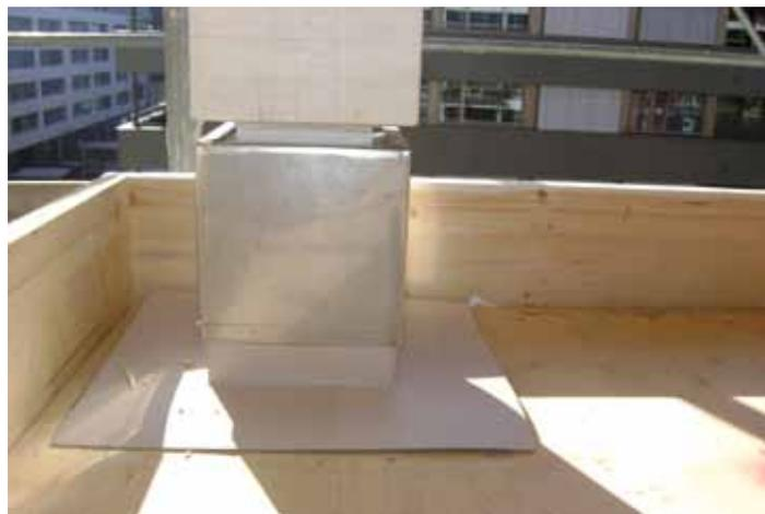
Eigens für dieses Projekt wurden massgenaue Sarnafil-Formteile für die über 450 Stützen produziert.
