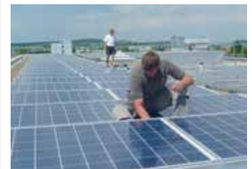
Module einlegen, auf der Unterkonstruktion festschrauben und verschalten. Bild: BE Netz
