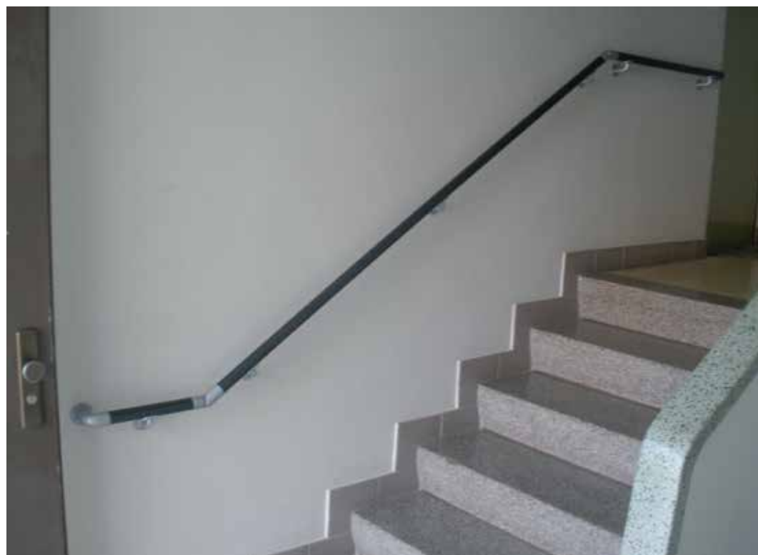
Nachgerüstet: Handläufe in Wohnanlagen mit beidseitigem Handlauf aus Stahlrohren mit Laminat im Dekor «Schwarz-Silberstreif»
