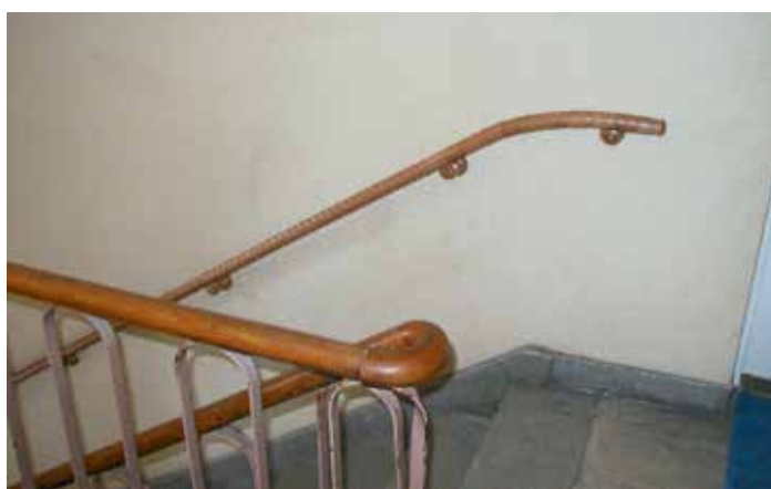
Nachgerüstet mit einem griffigen Holzhandlauf
