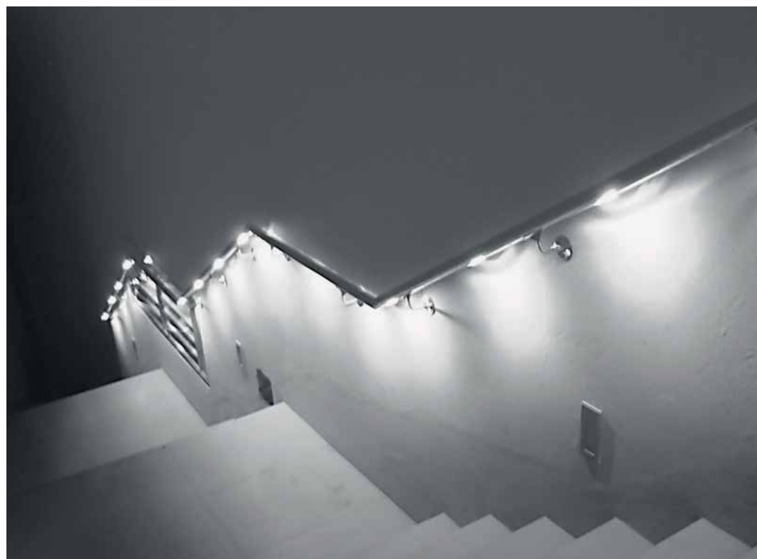
Wandhandlauf mit Licht, eine preiswerte Lösung für mehr Sicherheit an Treppen
