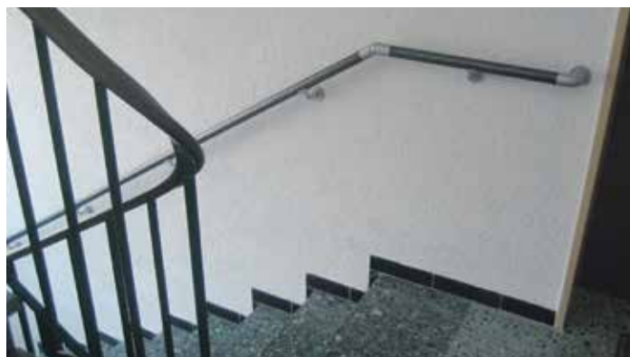
Nachgerüstet mit Flexo-Handläufe im Dekor «schwarz-silber» in einer Wohnanlage
