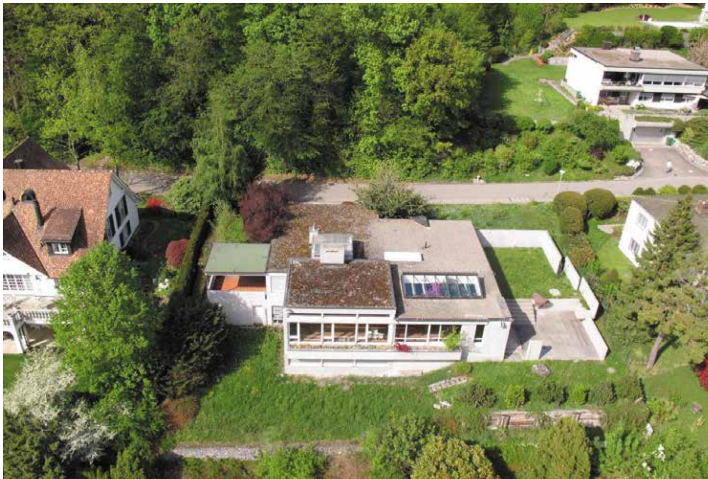
Vorher: Das Grundstück an bester Lage mit dem abbruchreifen Einfamilienhaus mit 340m 2 Nutzfläche.
