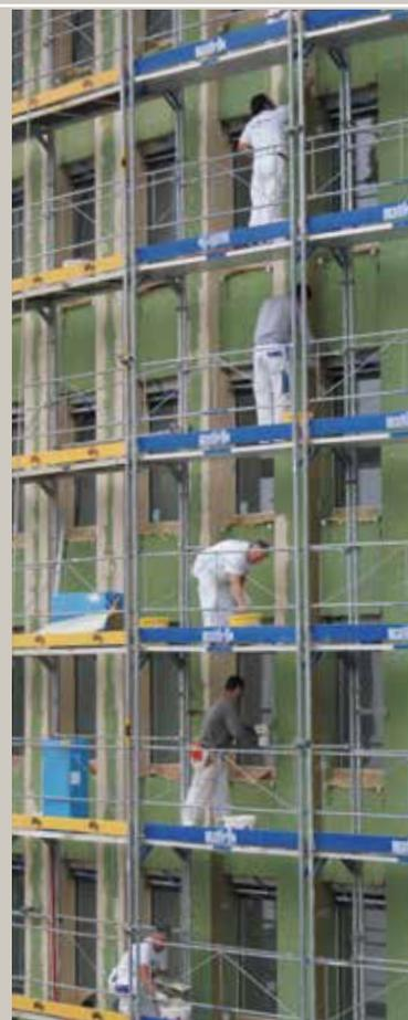
Bei zweischaligen Konstruktionen limitieren die Zweischalenanker die maximalen Schalenabstände und somit den möglichen Wärmeschutz. Bei hinterlüfteten Bekleidungen durchdringen Elemente der Unterkonstruktion die Wärmedämmschicht und können dadurch je nach Materialisierung gute U-Werte verunmöglichen (Foto: Flumroc).
