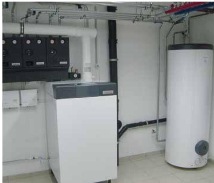
Der Einbau eines Thermo Condens von Weishaupt erwies sich als die zweckmässigste Sanierungsvariante. Foto Härrli
