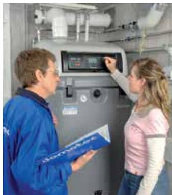
Auf nur 0,36 m<sup>2</sup> bzw. 0,64 m<sup>2</sup> sind die komplette Heizung, die Warmwasserbereitung und ein 300 l bzw. 500 l Solar-Schicht-Speicher untergebracht. Bei dieser kompakten Bauweise ist der Wärmeerzeuger (Gas-Brennwertkessel oder Luft- / Wasser-Wärmepumpe) bereits in den Solarspeicher integriert, was den Platzbedarf und auch den Installationsaufwand minimiert.
