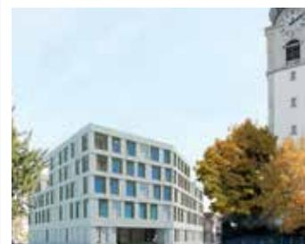
Die beeindruckende Fassade ist vorgehängt und hinterlüftet. Auf optimalen Schallschutz wird grössten Wert gelegt
