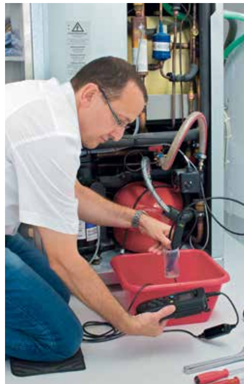
Sorgfältige Wasseranalyse vor der Sanierung
