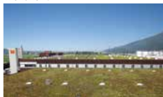
Blick über die weitläufigen Dachflächen des Hauptgebäudes.
