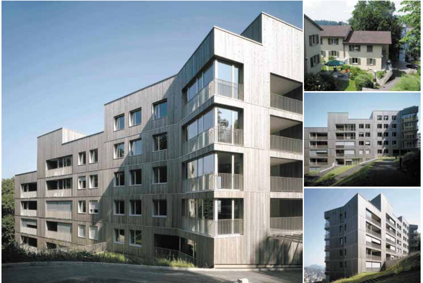
Neu ersetzt alt – der Ersatzneubau umfasst 8300 m 2 Energiebezugsfläche, verteilt auf 56 Wohnungen mit durchschnittlich 104 m 2 Wohnfläche. Fotos: Reinhard Zimmermann
