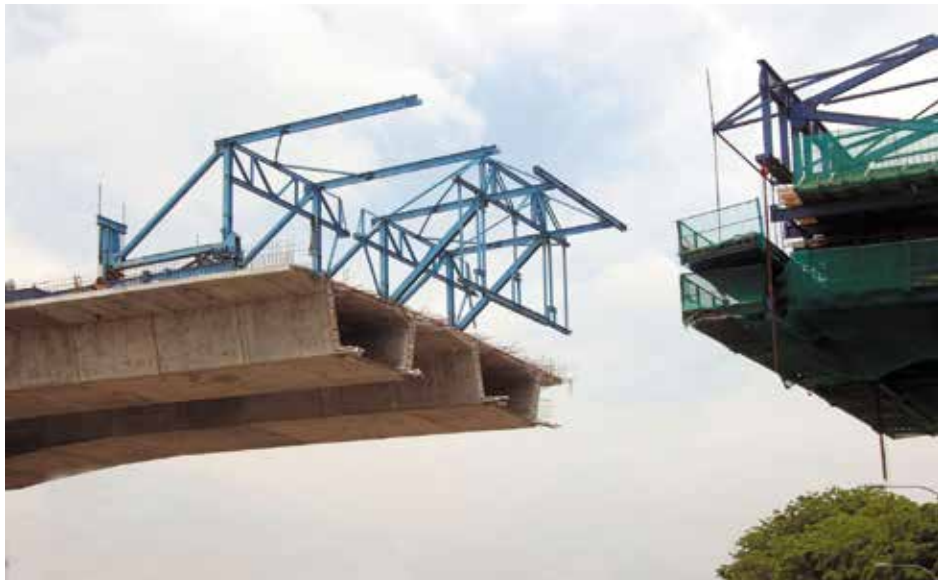
SIA 118 – ein Brückenschlag zwischen Bauherr und Unternehmen (Foto: Heng Kong Chen, 123rf.com).
