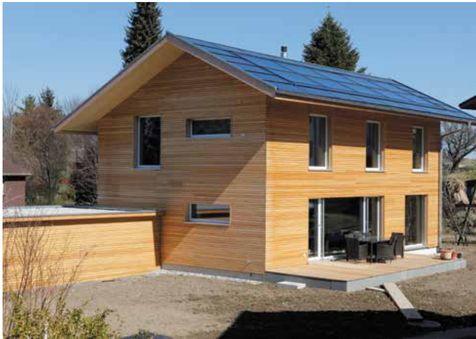
Das Plusenergiehaus in Schwarzenburg ist mit einer Kombi-Indach-Anlage ausgerüstet, was bedeutet, dass auf dem Dach gleichzeitig Wärme und Strom erzeugt wird (Bild: Schweizer Metallbau).
