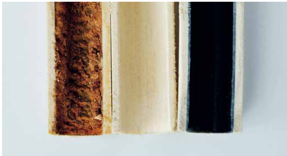
Heizrohr: vor, während und nach der Sanierung
