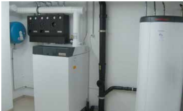
Wird auf diesen Produkten bald auch in der Schweiz eine Energieetikette aufgeklebt werden müssen? Brennkessel in Kombination mit einem Wassererwärmer (Foto: Härri (Weishaupt))
