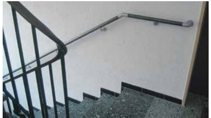
Nachgerüstet mit Flexo-Handläufe im Dekor «schwarz-silber» in einer Wohnanlage
