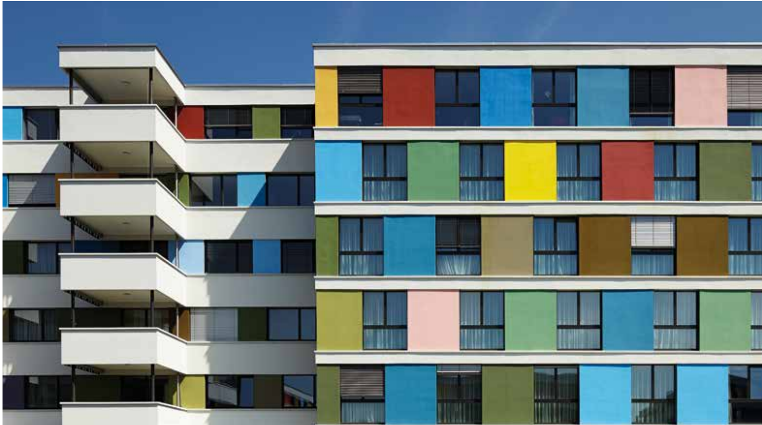
Die farbigen Flächen und leicht versetzten Fenster lassen die streng geometrischen Bauten spielerisch und leicht aussehen.
