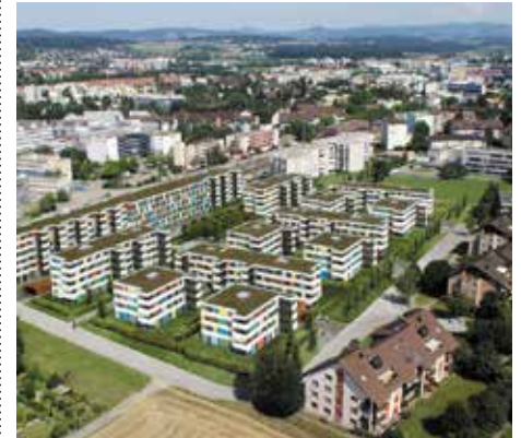
Mit der Überbauung ist in Schwerzenbach ein neues Quartier entstanden.
