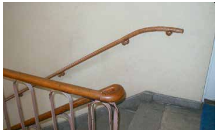
Nachgerüstet mit einem griffigen Holzhandlauf
