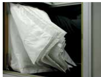
Abb. 1: Wenig eigenstabiles, herkömmliches synthetisches Taschenfilter
