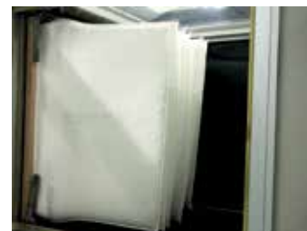
Abb. 2: Eigenstabiles SynaWave Taschenfilter
