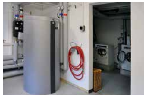
Grosses Bild: Das renovierte und energetisch sanierte Haus in Thalwil. Rechts von oben nach unten: Die stromerzeugende Heizung Vitotwin 300-W. Der 400 l-Speicher für das Warmwasser. Der zum Vitotwin gehörende 750 l-Kombispeicher.
