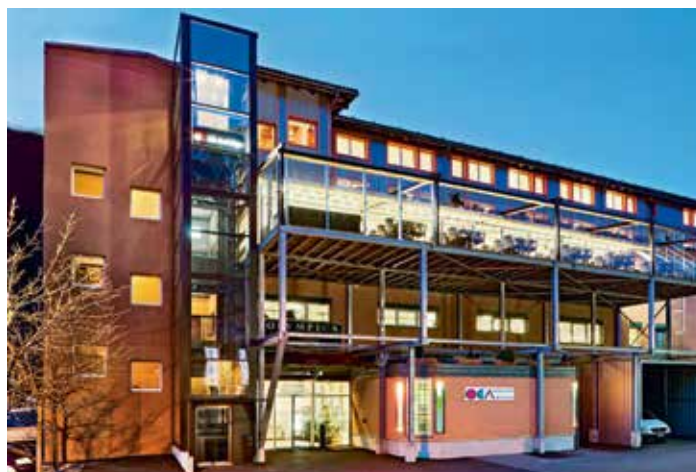
In den grosszügigen Sport- und Wellnessanlagen des Olympica treffen sich Feriengäste und Einheimische. Der neue Aussenlift von AS erleichtert vor allem den Rollstuhlfahrern die Mobilität enorm.
