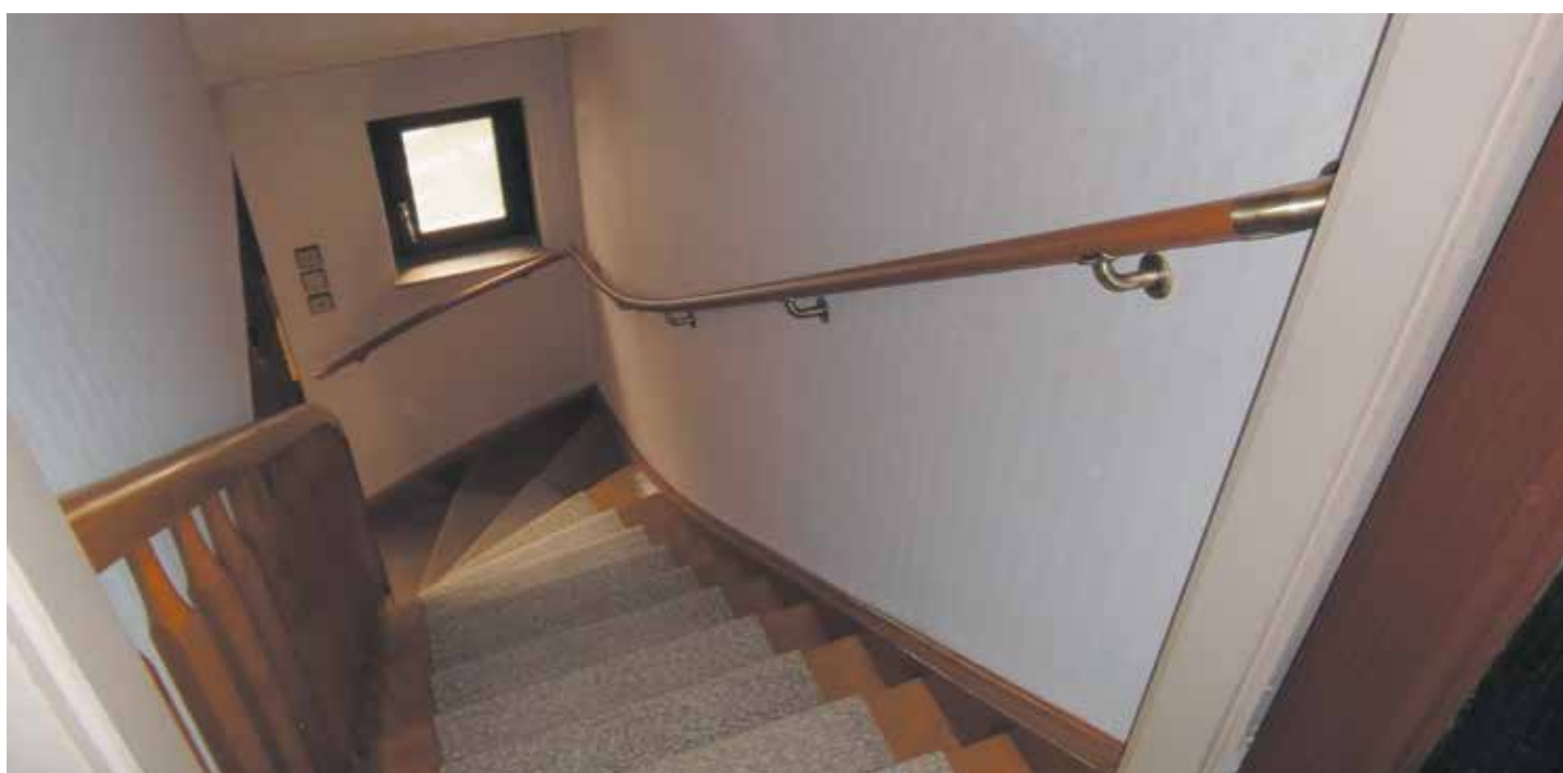
Innenhandlauf an der Wandseite, dort wo die Stufen breiter und sicherer sind
