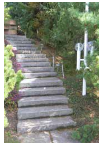
Fehlt hier ein Handlauf?
