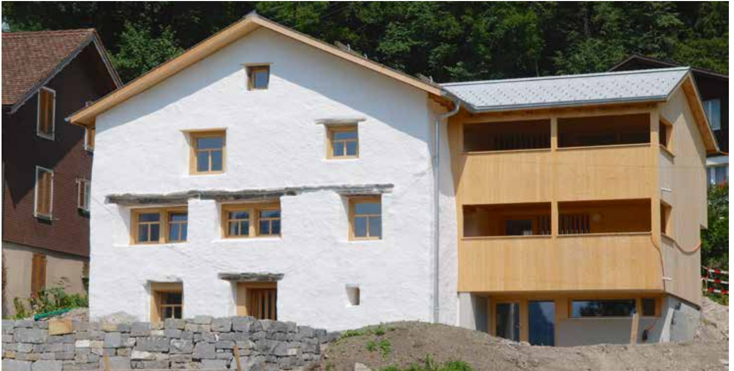
Die Alte Sust in Brunnen in neuem Glanz. Bilder nächste Seite, rechts: alte Bausubstanz vor der Sanierung.
