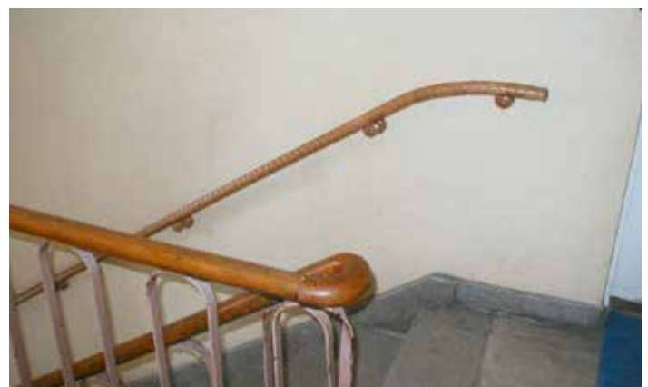
Nachgerüstet mit einem griffigen Holzhandlauf
