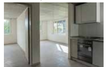
Keramische Plattenbeläge und Kalkzementputz an den Wänden. Bild Simon Zangger
