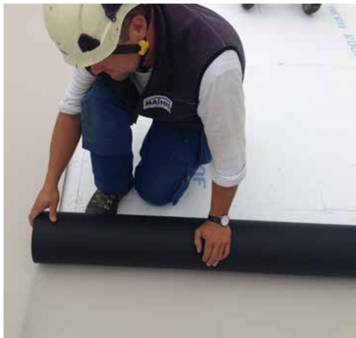
Effizientes Arbeiten: Über die S-Therm Wärmedämmung konnten schnell und einfach die Sarnafil Kunststoffabdichtungsbahnen ausgerollt werden.
