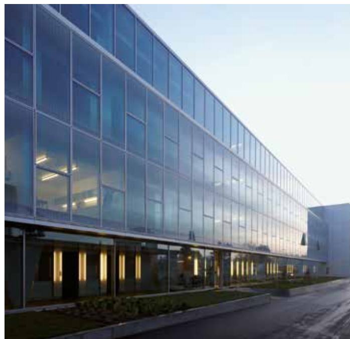
Spital Zollikerberg: Die Glasfassade als prägendes Element des «Westtrakt-Riegels» widerspiegelt die in den Innenräumen fortgesetzte Grosszügigkeit und Helligkeit.
