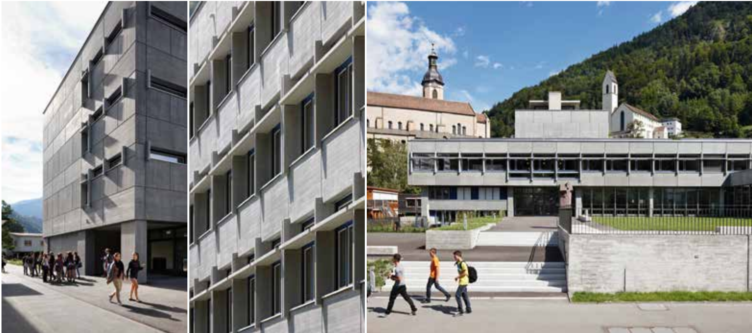
Die neuen Sichtbetonelemente der Fassadenverkleidung – wie damals in roher Sägebrettoberfläche – verändern das Aussehen des Gebäudeensembles nur unwesentlich. Die Wärmedämmung und die Fenster wurden umfassend im Minergie®-Standard erneuert.
