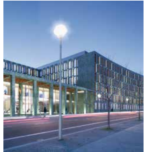
Öffentliche Aufgaben mit privater Finanzierung: PPP-Projekt Bundesministerium für Bildung und Forschung in Berlin.
