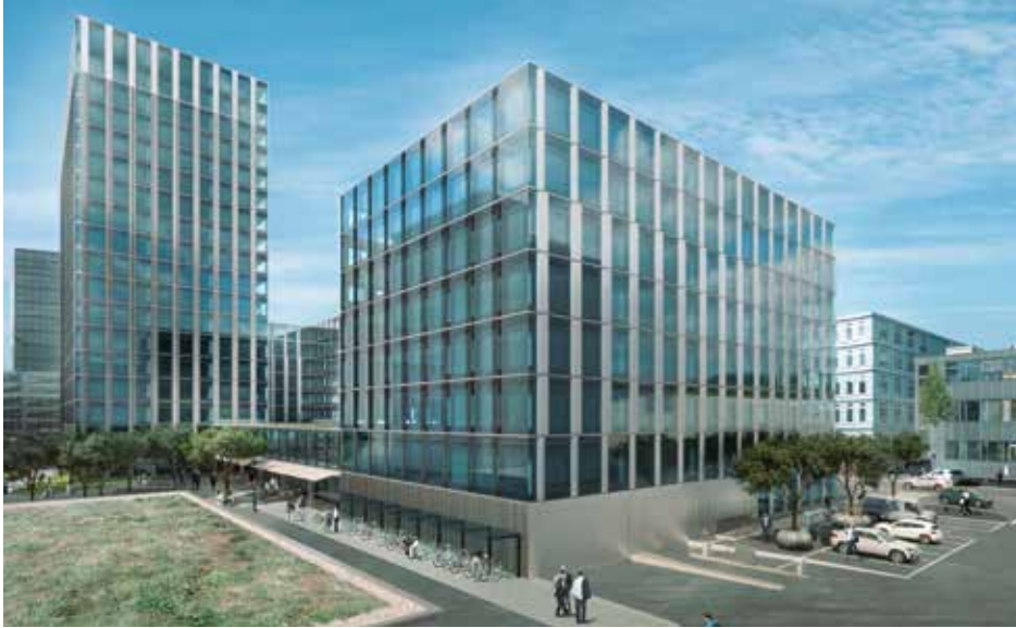
SkyKey in Zürich Leutschenbach ist mit einem Investitionsvolumen von rund 240 Mio. CHF eines der grössten aktuell laufenden Projekte von SPS. Mitte Jahr ziehen die Zürich Versicherungen ein.
