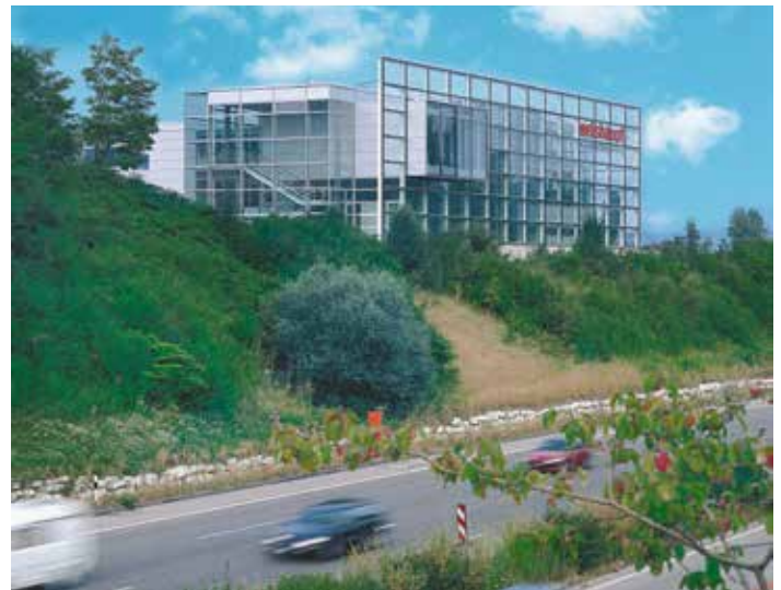
Das Verwaltungs- und Schulungszentrum in Geroldswil – direkt an der Autobahn – ist ein Kompetenzzentrum zur Aus- und Weiterbildung von Fachleuten. (Bilder: zVg)
