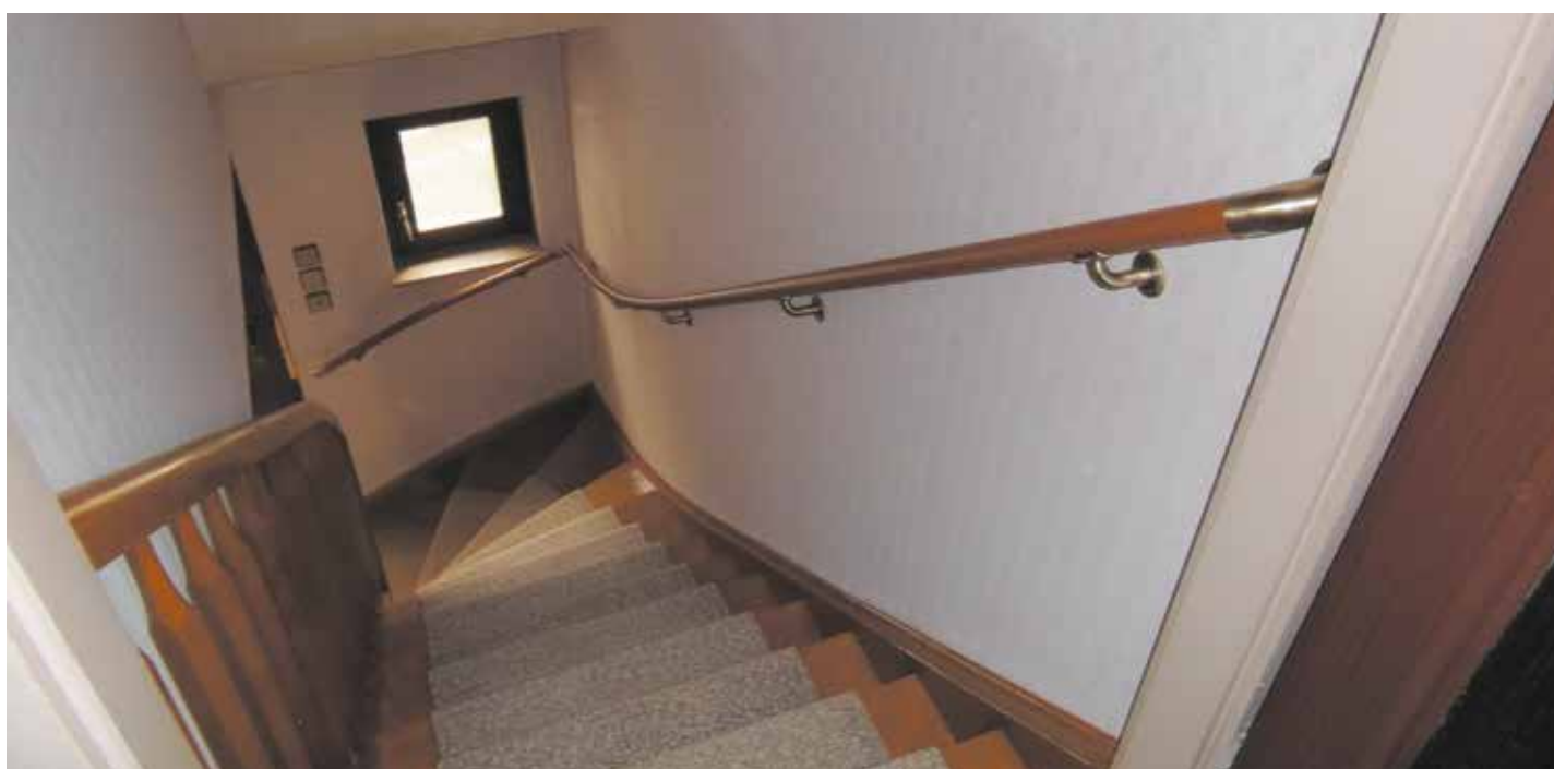
Handlauf an der Wandseite, dort wo die Stufen breiter und sicherer sind.
