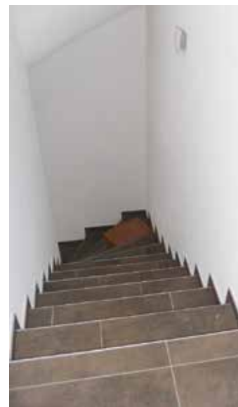
Brauche ich hier einen Handlauf?
