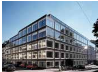
Züblin-Liegenschaft an der Holbeinstrasse 22/30, Zürich
