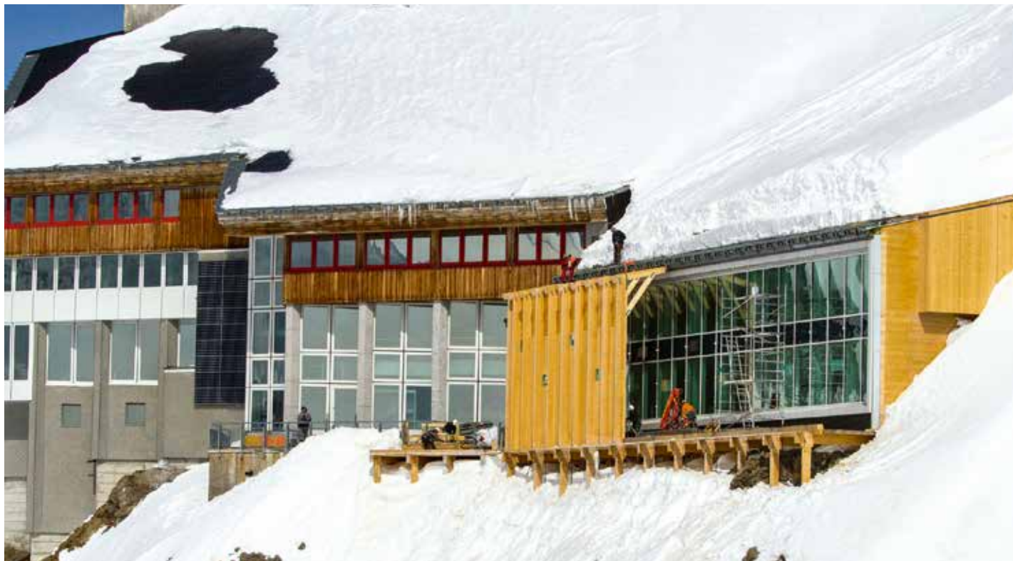
So sieht die neue Glasfassade des Gletscherrestaurants auf dem Jungfraujoch aus. Wegen Temperaturen bis minus 30 Grad musste ein Schutzhaus erstellt werden.
