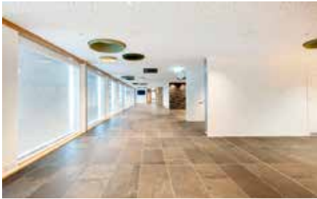
Beim Innenausbau wurden Materialien wie Natureiche, dunkle keramische Bodenplatten und eine Akustikstreulochdecke verwendet.
