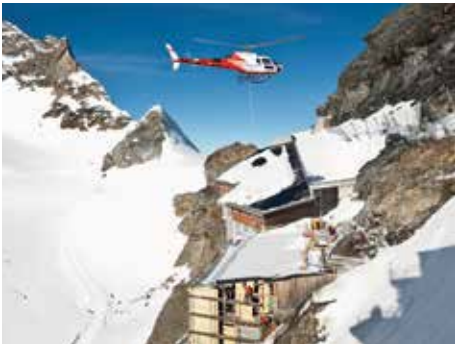
Da man auf dem Berggipfel keinen Kran aufstellen konnte, wurde das Baumaterial mit einem Helikopter transportiert. (Fotos: Kaspar Bacher)
