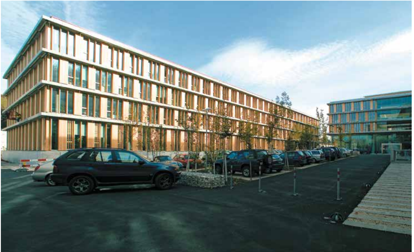
Verwaltungszentrum UVEK, Ittigen BE, dient dem Lehrgang CAS Facility Management KBOB als Leitimmobilie und Praxisbeispiel für die Module 1–7 des Lehrgangs dient (Foto: Dominique Uldry).
