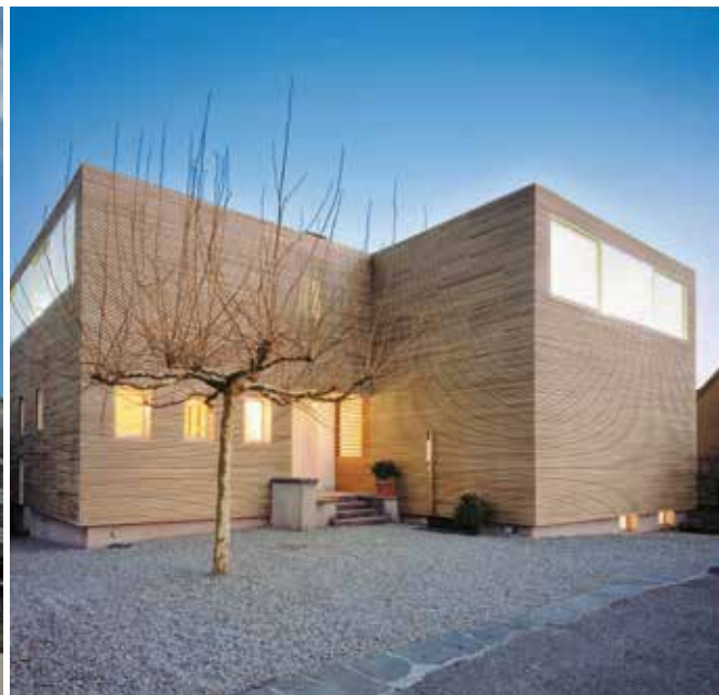
Aufstockung einer Lausanner Villa: Im 150 m 2 grossen Dachgeschoss ist ein Architekturbüro untergebracht.
