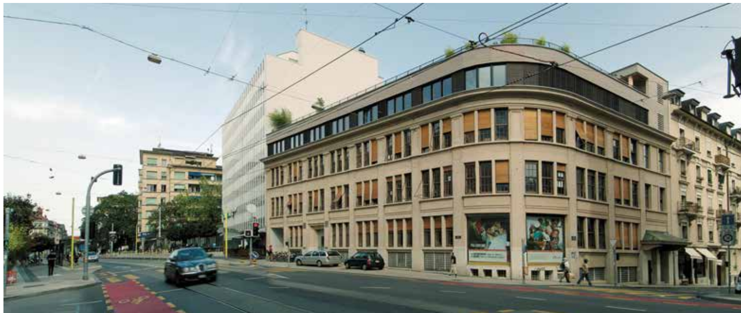
Bürogebäude für «Ärzte ohne Grenzen» in Genf: Das zusätzliche Geschoss aus Holz bietet Raum für 30 Arbeitsplätze und zwei Sitzungszimmer. (Fotos: Corinne Cuendet)
