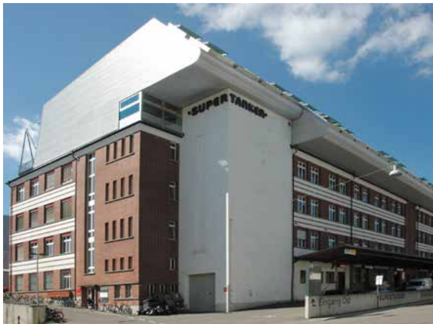
Zürichs «Supertanker» im Binz-Quartier: Die Aufstockung ist 100 Meter lang, 23 Meter tief und erstreckt sich über zwei Geschosse. Durch eine Auskrägung zur Strassenseite und der rückspringenden Fassade auf der Südseite wurde eine geräumige Dachterrasse gewonnen. (Foto: Michael Meuter)
