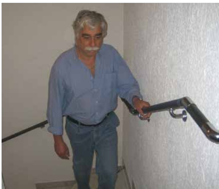
Ein Handlauf an der Wandseite gibt mehr Sicherheit für Jung und Alt.
