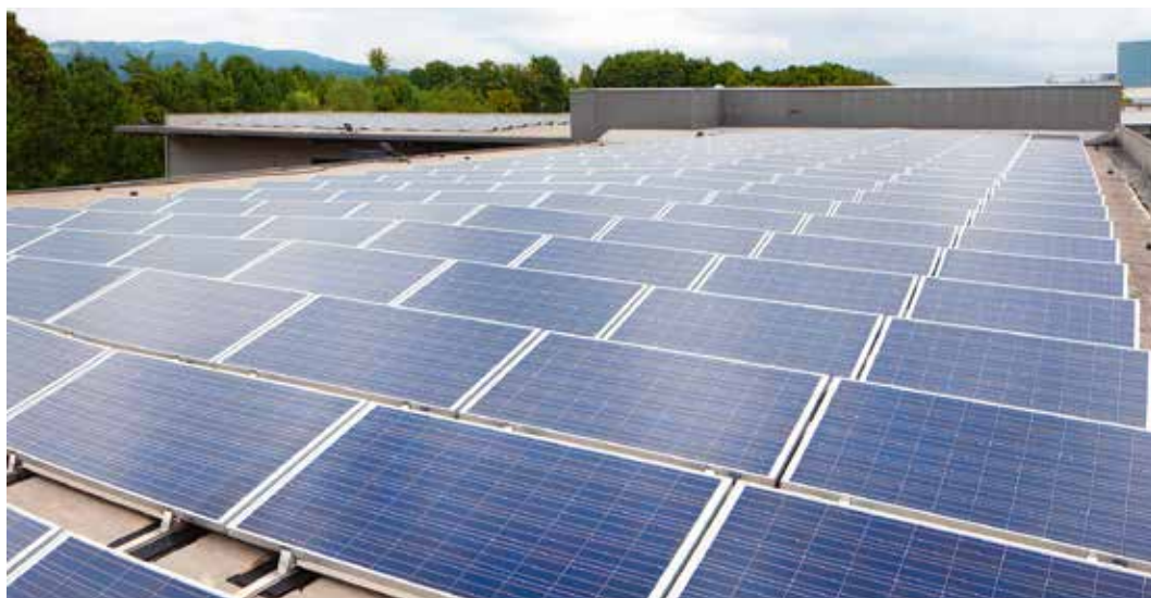
Das modulare und bewährte Photovoltaik-Montagesystem VIVATfix® ist aerodynamisch optimiert, im Windkanal getestet und eignet sich bestens für Folien-, Bitumen- und bekiesete Flachdächer.
