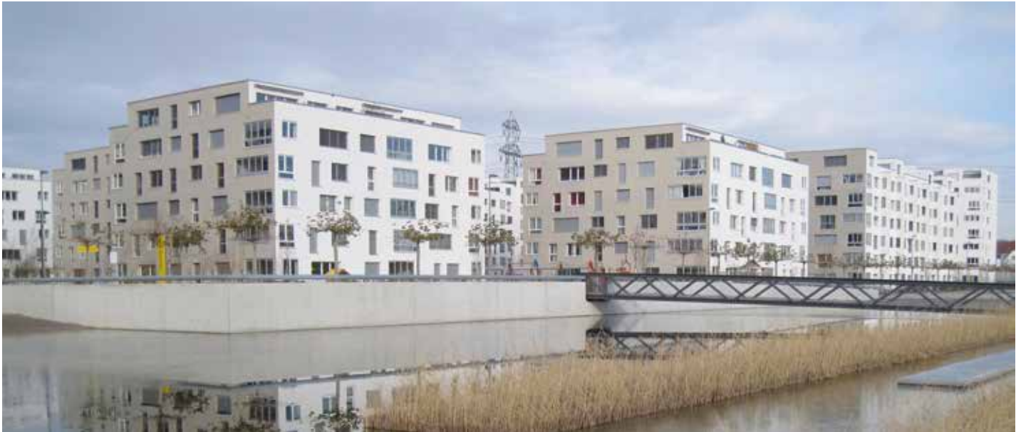
Die Wohnbautätigkeit wird voraussichtlich auch 2014 und 2015 auf hohem Niveau verharren (Bild: Glattpark Opfikon).
