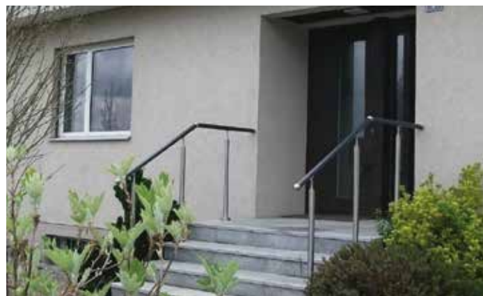
Beidseitiger Handlauf auch bei wenigen Stufen vor dem Hauseingang
