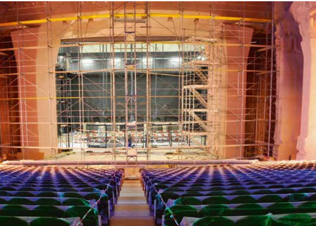
Ein Blick aus dem grossen Goetheanum-Saal auf die eingerüstete Bühne (Fotos: Anna Krygier).
