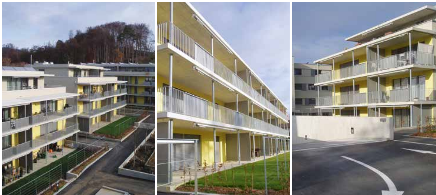
Der Wohnpark Hättenberg in Ostermündigen wurde sowohl an das FTTH-Netz der Swisscom als auch an das Kabelnetz der upc cablecom angeschlossen.
