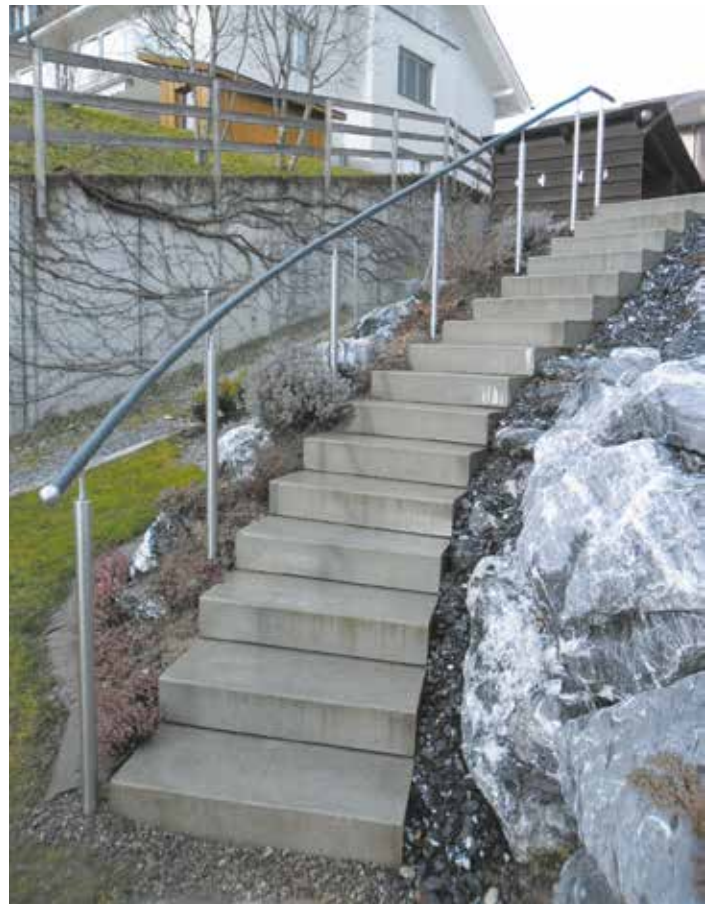
Geschwungener Handlauf aus handwarmen Aluminium auf Chromstahl-Stützen.
