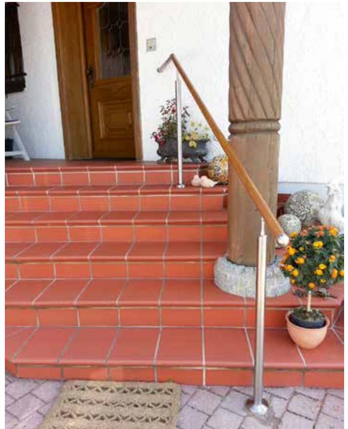
Bei älteren Bewohnern sind manchmal beidseitige Handläufe sinnvoll und sicherer
