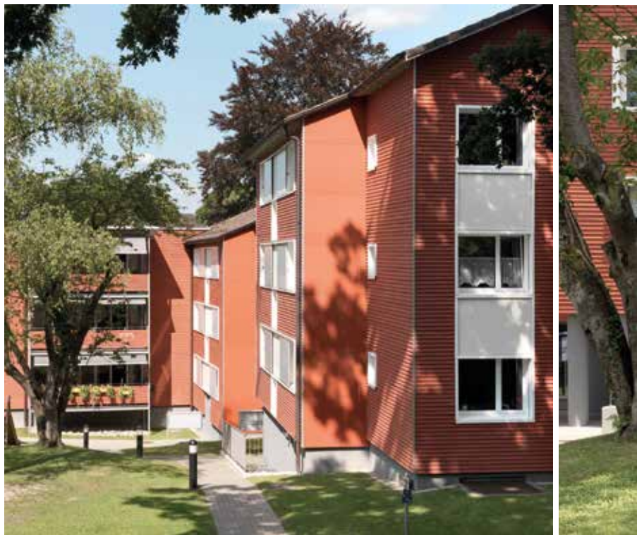
Bilder rechts: In der Wohnsiedlung Waidmatt in Zürich-Affoltern ermöglichen bewährte bauliche Massnahmen wie Wärmedämmung, bessere Fenster und mechanische Lüftung eine Halbierung des Energieverbrauchs – trotz Erweiterung der Wohnfläche (Fotos: Bruno Helbling).
