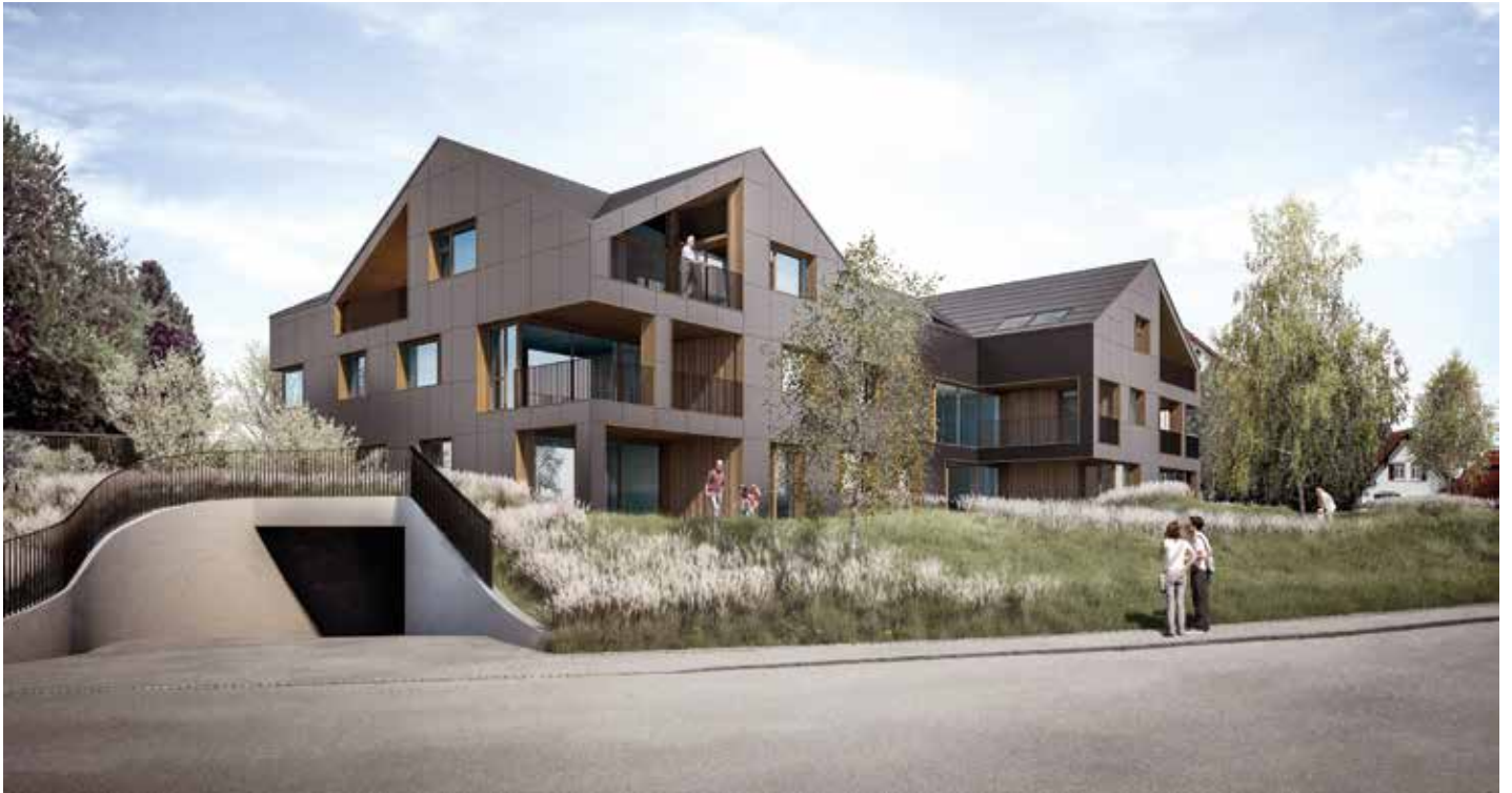
Das geplante energieautarke Mehrfamilienhaus in Brütten ZH, dessen Fassaden vollflächig mit Fotovoltaik-Modulen bedeckt sind (Visualisierung: zvg).
