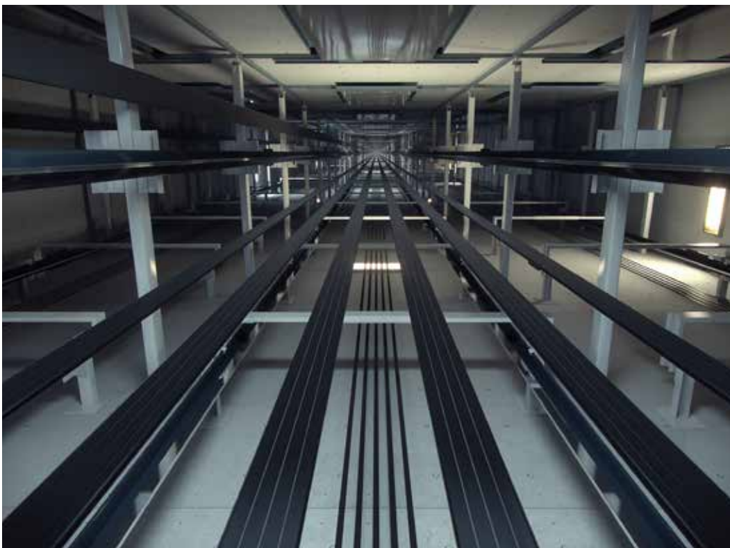
Kone UltraRope ermöglicht eine maximale Förderhöhe von bis zu einem Kilometer
