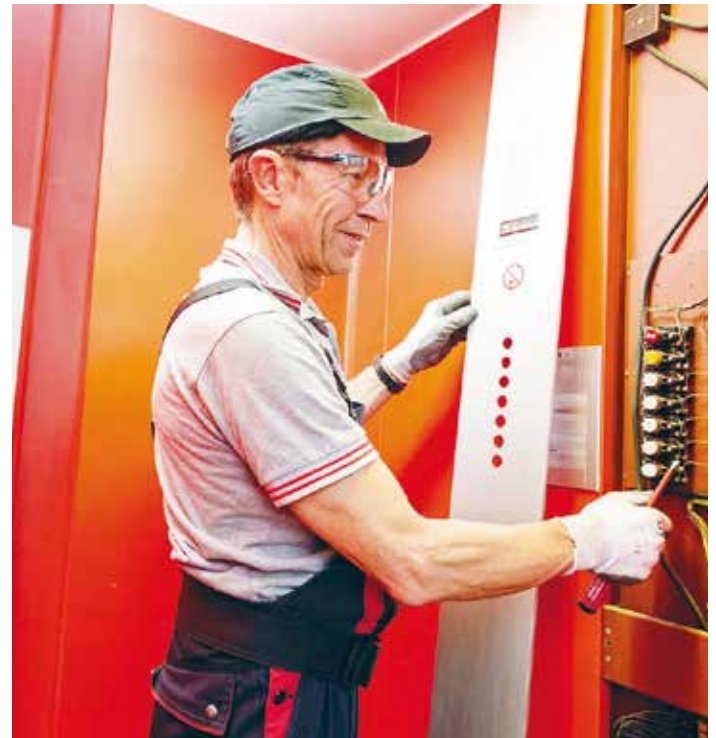
Durch gezielte Messungen wird die Störungsursache zügig gefunden.
