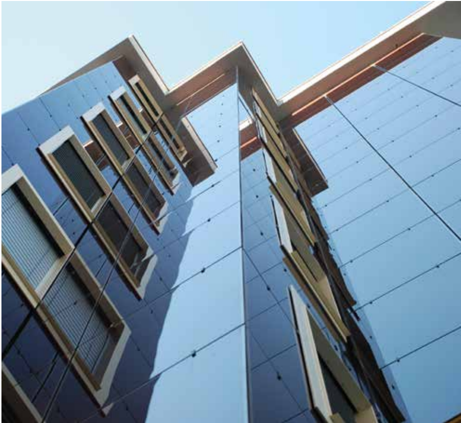
Sanierte Fassade aus Hochleistungs-Photovoltaikmodulen (Bild 1).
