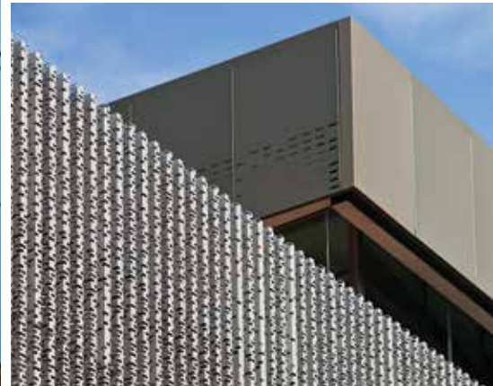
Metallfassade aus korrosionsbeständigen Aluminiumblechen (Bild 4).
