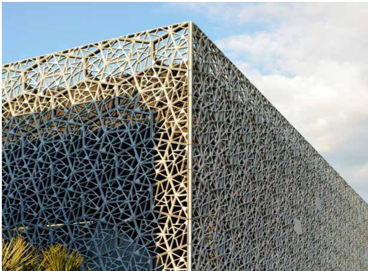
Fassadennetz aus transparenten Betonelementen (Bild 2).
