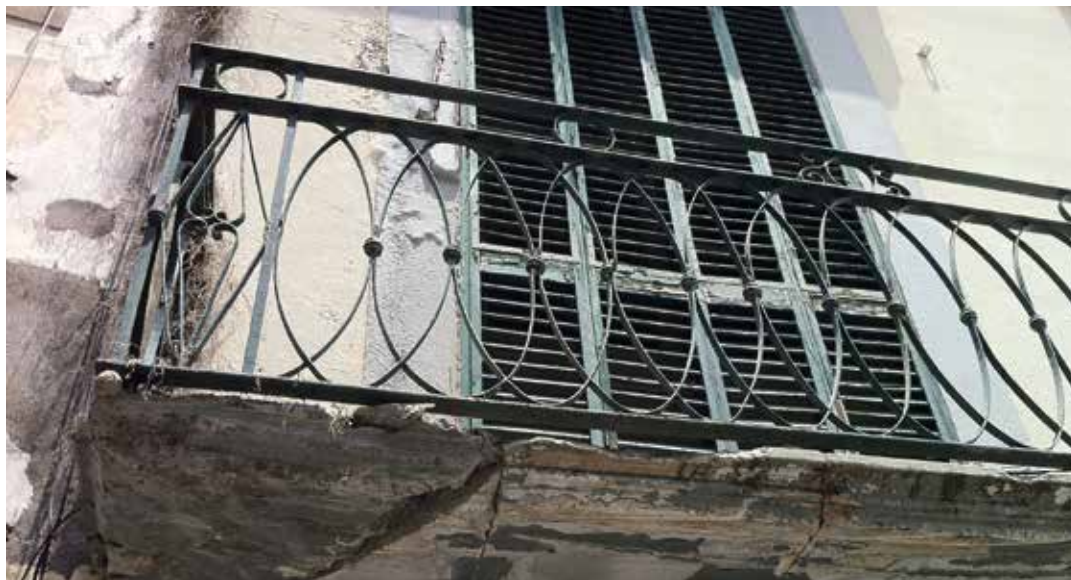
Abplatzungen: zwei Beispiele aus der Baupraxis, die zeigen, welche Schäden eine Betonkarbonatisierung anrichten kann.
