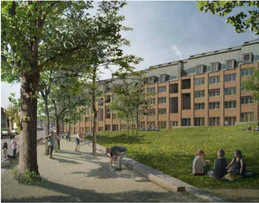
Bis 2017 entsteht an der Zürcher Rosengartenstrasse ein Studentenwohnheim mit 130 Zimmern.
