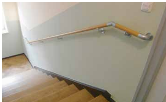
Handlauf in einer Wohnanlage mit Knick nach Norm, hier Ausführung in Buche hell.
