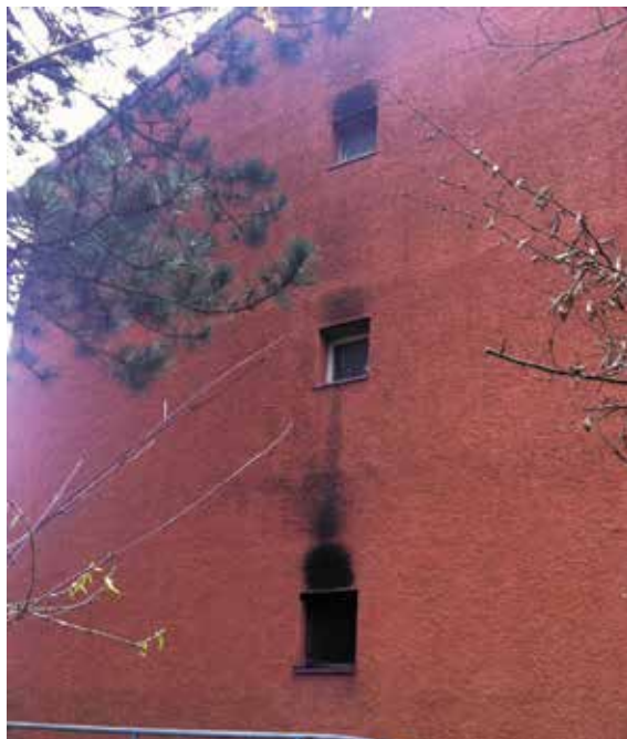
Schwarzer Schimmel an der Fassade durch Dauerlüften.
