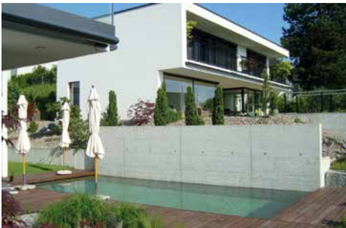
Die Solarkollektoren unterstützen die Poolbeheizung beim Einfamilienhaus Realini bei Bedarf.
