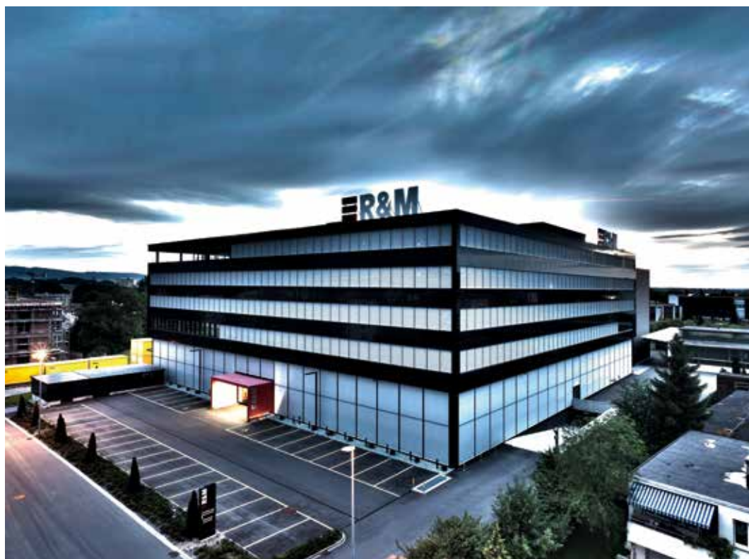
Mit 22 000 m 2 Gebäudefläche zählt der R&M-Kubus zu den grössten Low-Exergie-Büro-/Gewerbebauten der Schweiz. Foto: Kubus
