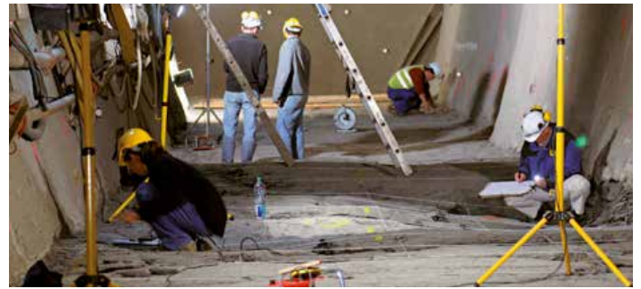
Bauarbeiten im Opalinuston: Erstellung der Galerie 08 im Felslabor Mont Terri.
