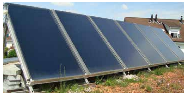
Die Solarkollektoren WTS-F2 sind speziell für die Aufdach- und Flachdachmontage konzipiert.
