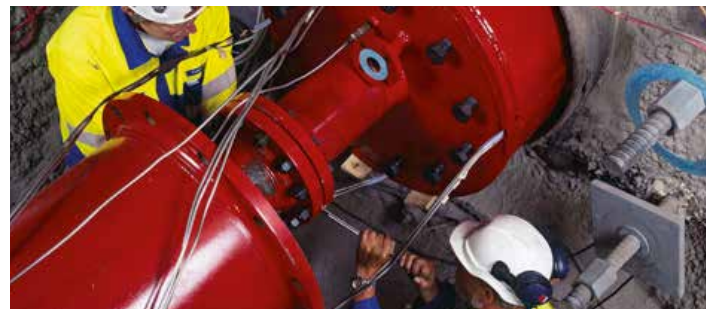
Einbau eines grossen Packers für einen wichtigen Gasversuch im Felslabor.
