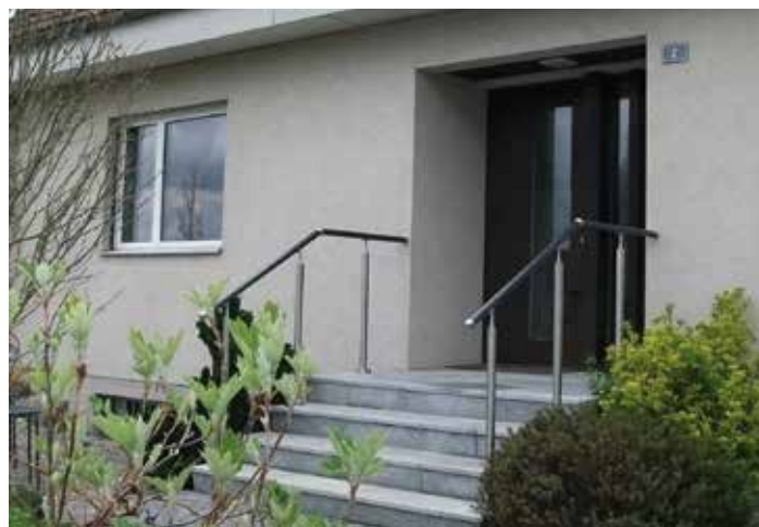
Beidseitiger Handlauf auch bei wenigen Stufen vor dem Hauseingang
