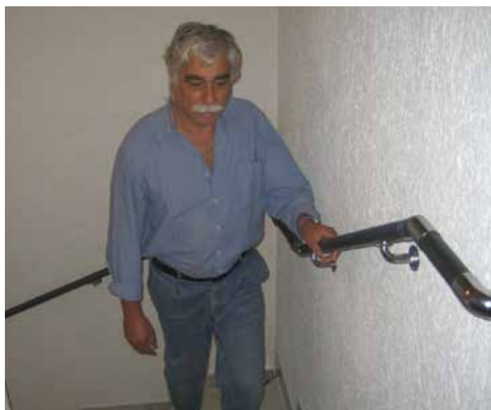
Ein Handlauf an der Wandseite gibt mehr Sicherheit für Jung und Alt.
