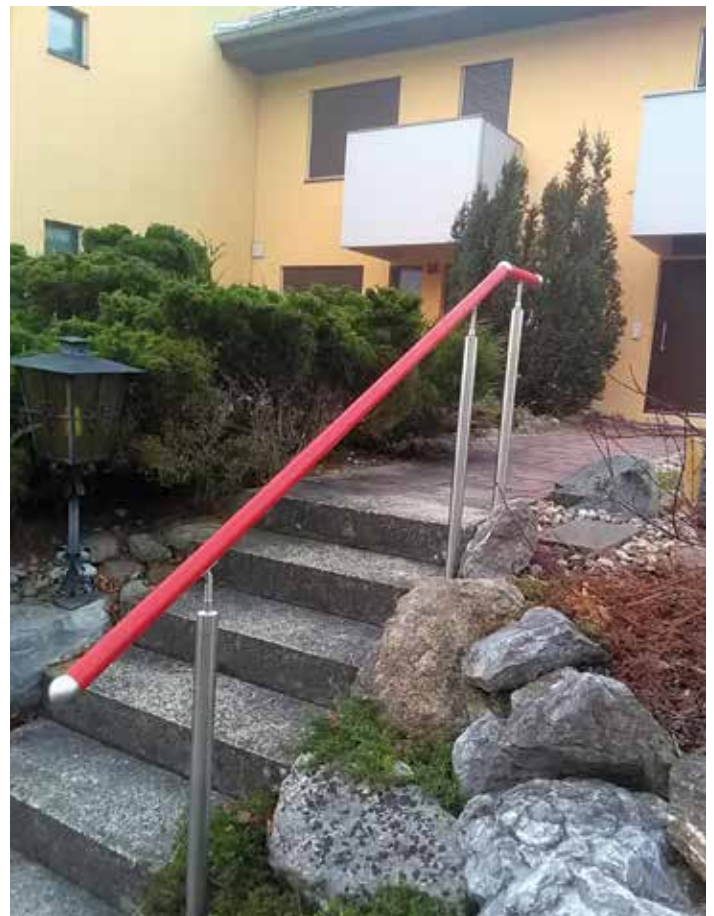
Farblich markanter Handlauf mit oberem Knick nach SIA Norm
