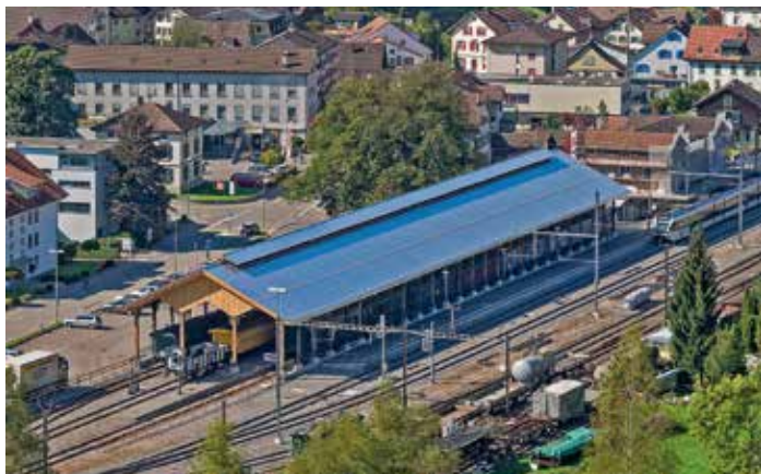
Die Perronhalle ist 104 m lang und 19 m breit. Sie ruht mit Eichenstützen auf 52 Fundamentsockeln. Für die Dimensionen der Halle wurde der Gleisverlauf angepasst.
