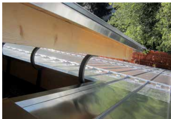
Die Dachlaterne war nicht mehr erhalten und ist eine komplette Neukonstruktion nach den ursprünglichen Plänen, aber mit einem modernen Tragwerk.
