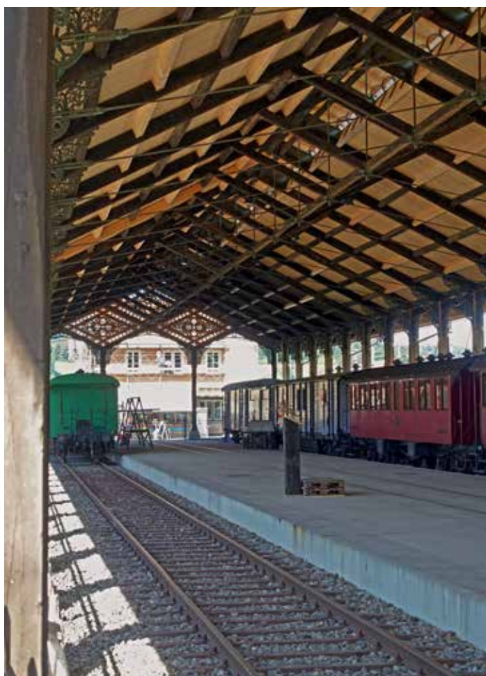
Die Perronhalle zwei Wochen vor der feierlichen Einweihung. Noch stehen Leitern und Gerüste herum, es wird überall gewerkelt, doch die Halle macht schon mächtig Eindruck. Die mit Zugstreben stabilisierte Dachkonstruktion benötigt keine mitigen Stützen, der Perron wirkt frei und grosszügig. Ganz bewusst wurden die ersetzten Teile ohne künstliche Alterung neben die historischen Teile gesetzt, Alt und Neu ergänzen sich in gemeinsamer Funktion. Nur im First, im offenen Bereich der Dachlaterne, lassen sich die Träger der verstärkenden Stahlkonstruktion erkennen.
