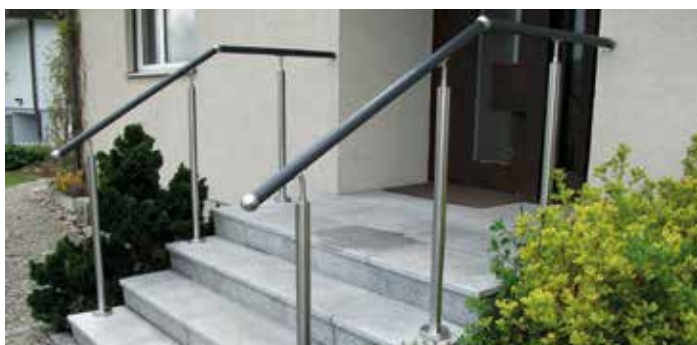
Beidseitiger Handlauf in handwarmen Aluminium mit Chromstahl-Stützen
