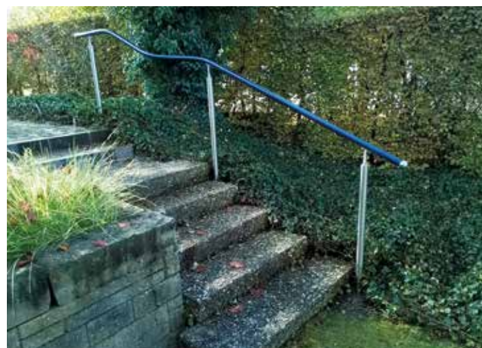
Stützen in Chromstahl inklusive der erforderlichen Erd- und Betonarbeiten, Handlauf jedoch aus handwarmen Aluminium mit Laminat in vielen Dekors möglich
