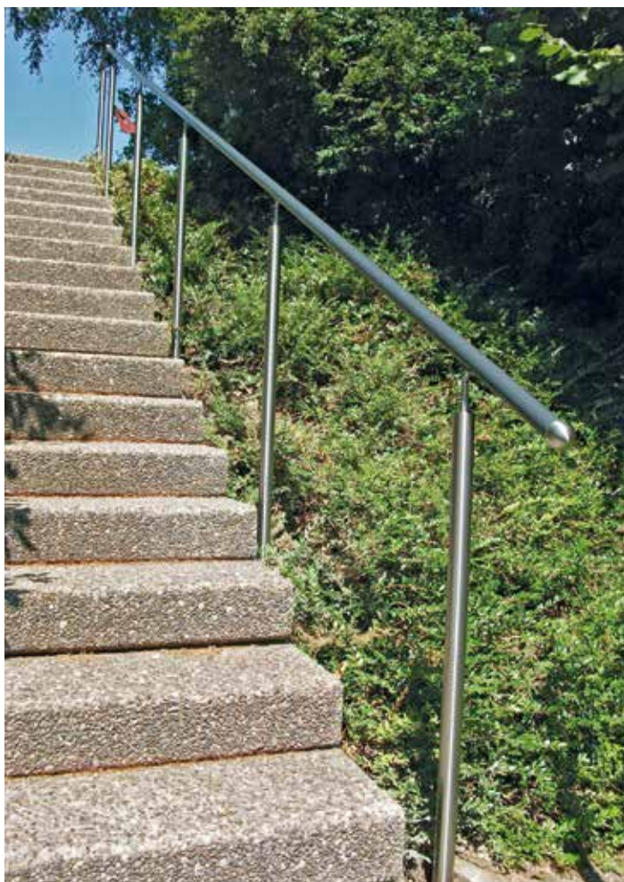
Stützen in Chromstahl inklusive der erforderlichen Erd- und Betonarbeiten, Handlauf jedoch aus handwarmen Aluminium mit Laminat in vielen Dekors möglich
