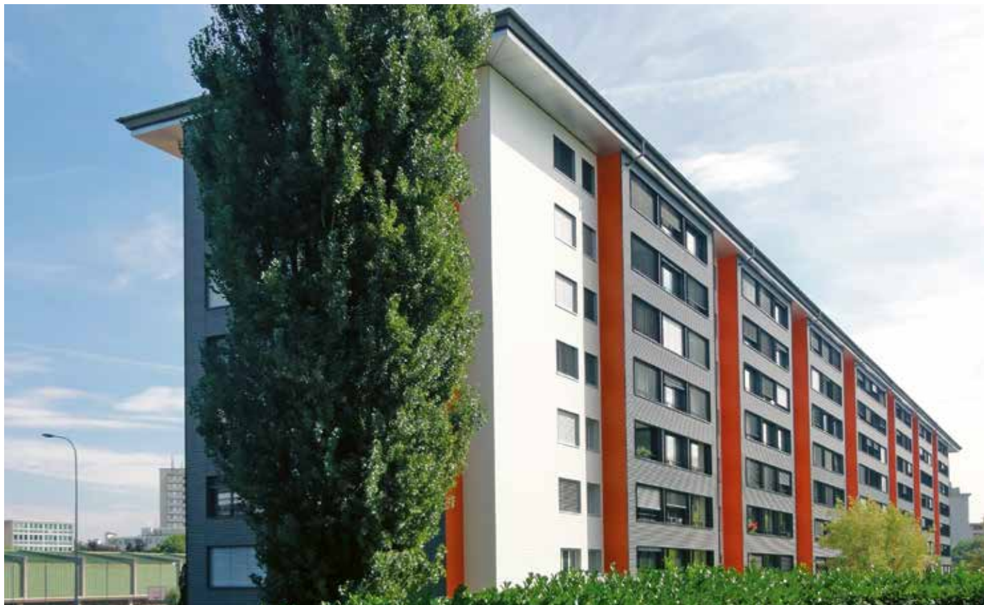
La Cigale in Genf: das grösste Minergie-P-Sanierungsprojekt der Romandie.
