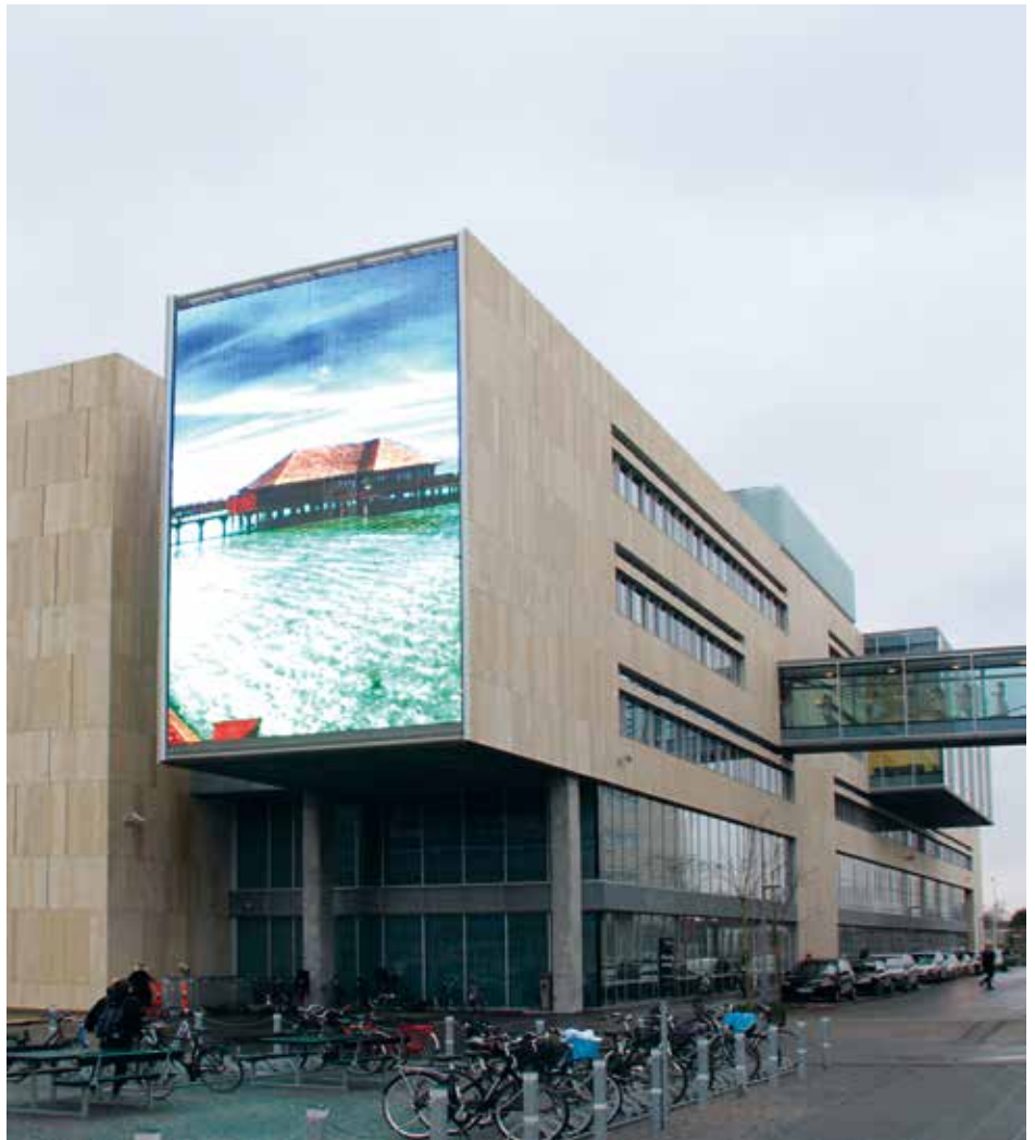
Die Medienfassade der Firma GKD reduziert an der verglasten Stirnseite die Sonneneinstrahlung, ohne die Aussicht zu beeinträchtigen (Fotos: impetus.PR).
