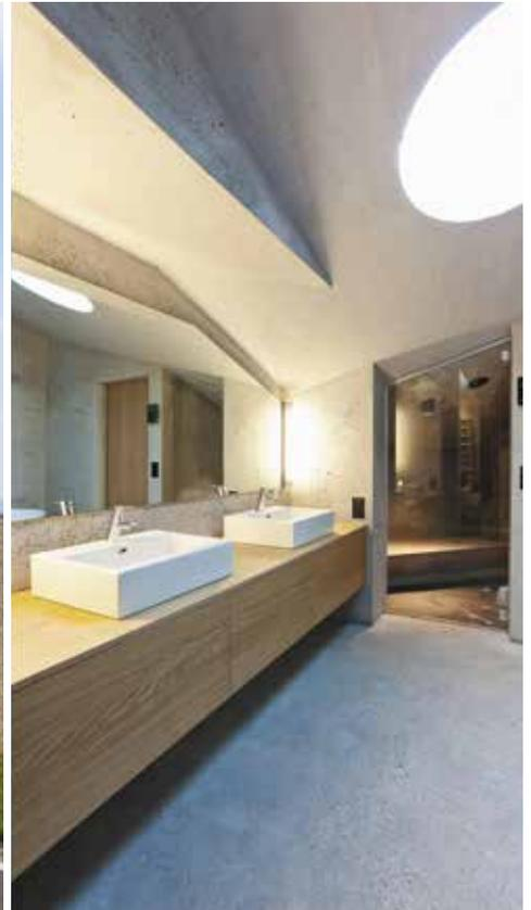
Haus Trovatello: Die Aussen- und Innenwände des monolithischen Baukörpers bestehen aus Wärmedämmbeton.
