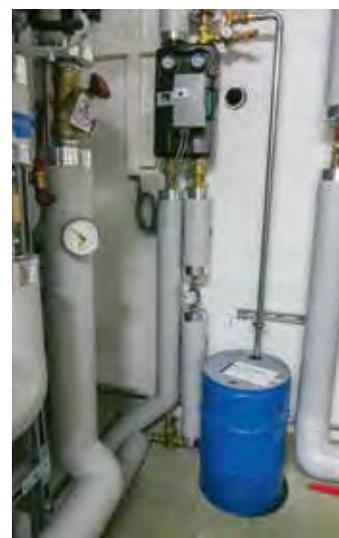
Solarstation mit Auffanggefäss sorgt für Sicherheit bei Überdruck
