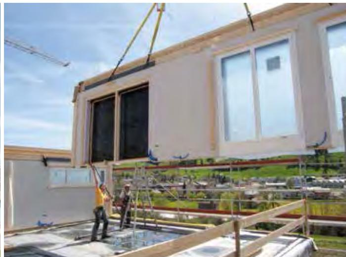
Bild links: Beispiel Wohn- und Geschäftshaus, Bulle. Heute darf ein Gebäude aus Holz bis 30 Meter Höhe ohne Sondergenehmigung gebaut werden. Bild rechts: Die Holzelementwand einer Wohnüberbauung in Einsiedeln wird montiert (Bilder: Strüby Konzept AG).
