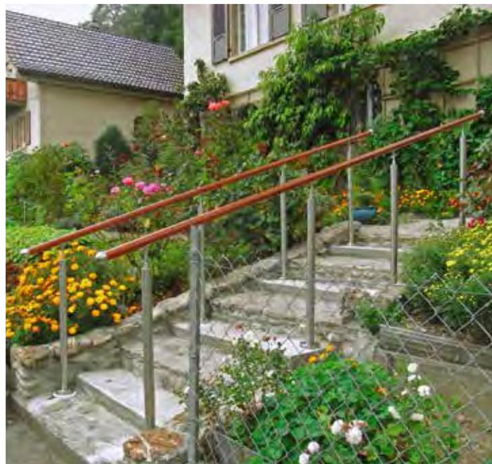
Beidseitiger Aluminiumhandlauf ummantelt mit einem Laminat und aufgeschraubten Chromstahlstützen.
