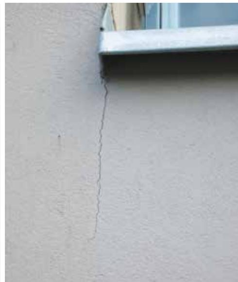
Die häufigsten Schäden an Bauwerken sind Rissbildungen an verputzten Fassaden.
