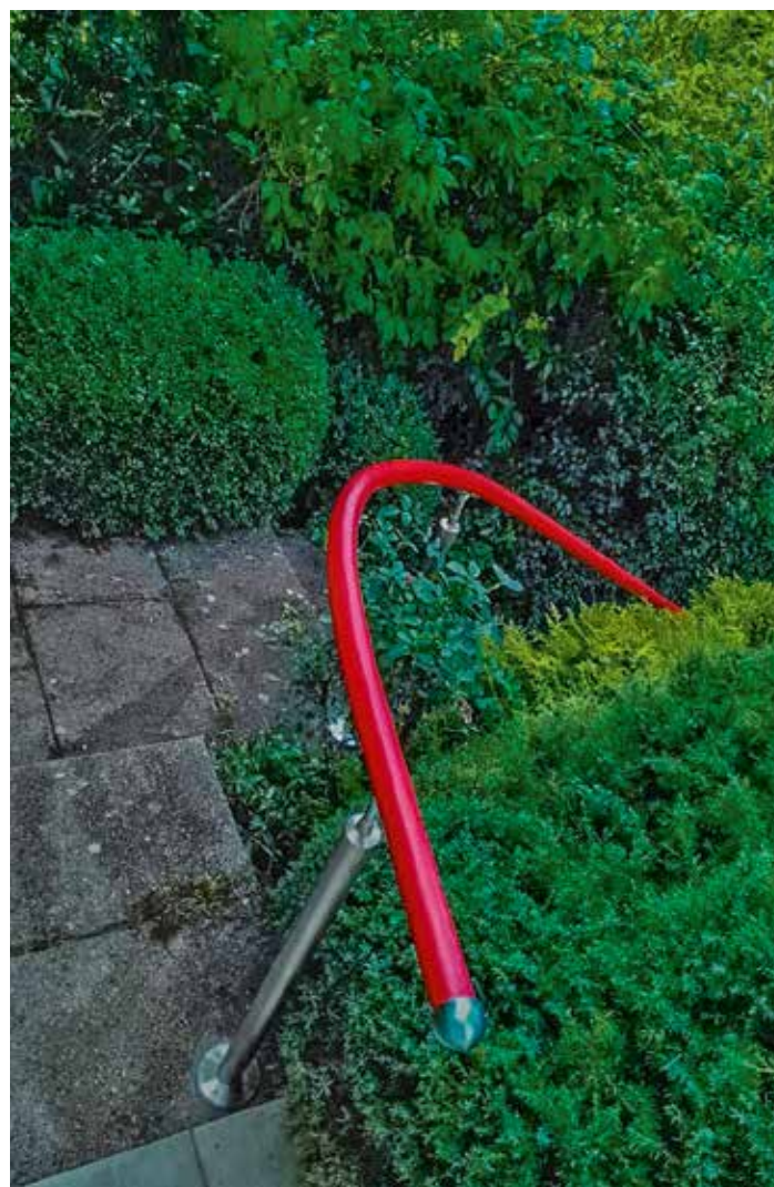
Aussenhandlauf in Rot mit aufgeschraubten Chromstahlstützen
