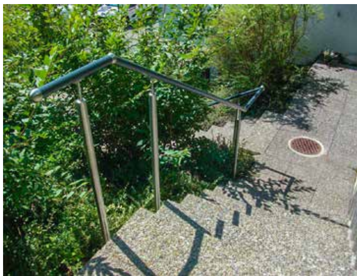
Aluminiumhandlauf mit einbetonierten Chromstahlstützen
