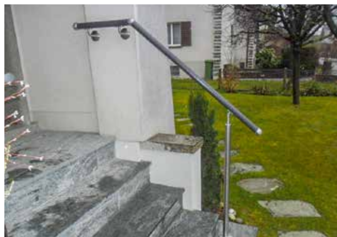
Aussenhandlauf mit aufgeschraubter Chromstahlstütze und Wandhalterung.
