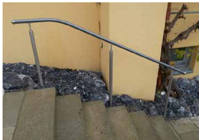
Handlauf auf Stützen, oben nach SIA Norm.
