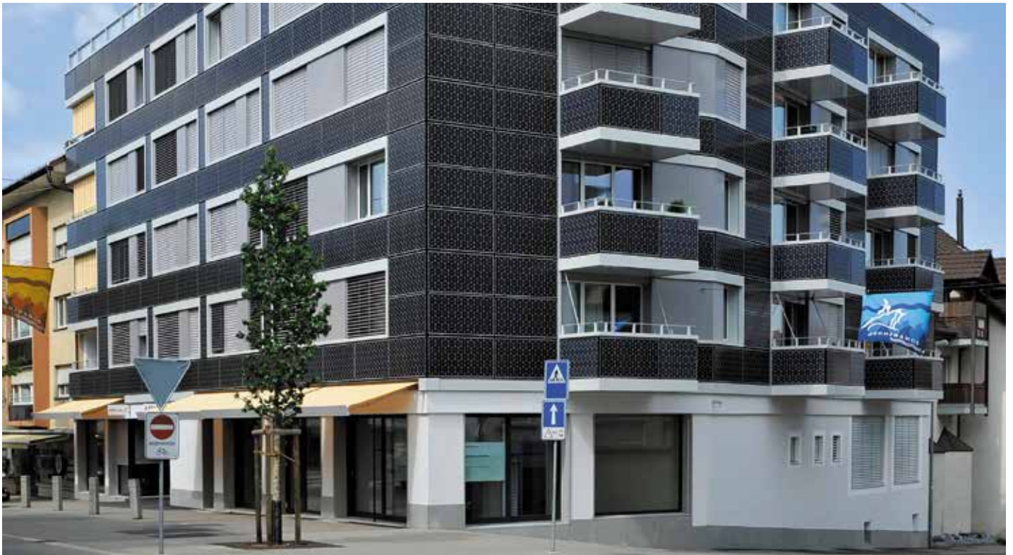
Das Projekt in Romanshorn heute: Dank umfassender Sanierung und fassadenintegrierten PV-Paneeelen ist ein Plusenergiehaus entstanden.
