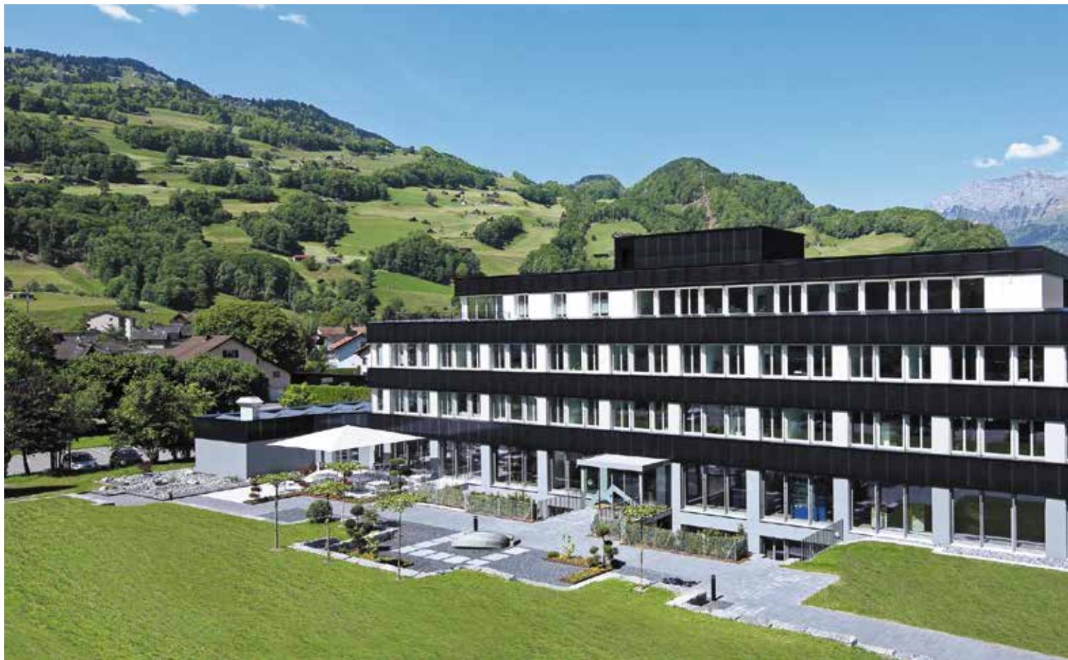
Die Fassade des Verwaltungsgebäudes von Flumroc ist an drei Seiten mit PV-Paneelen verkleidet – ausgezeichnet mit dem Norman Foster Solar Award 2014 (Bild: Flumroc).
