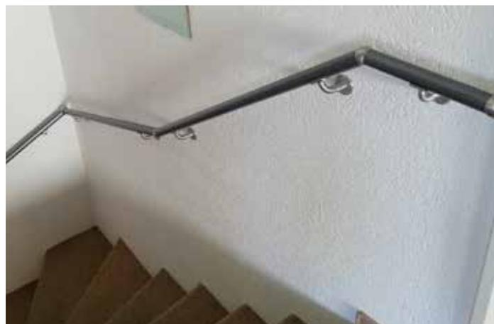
Durchlaufender Handlauf wandseitig mit Kugelverbindungen.
