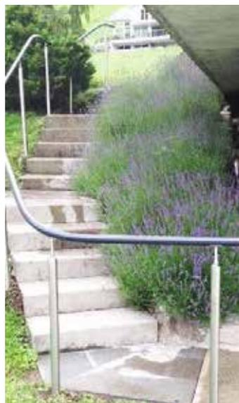
Geschwungener Aussenhandlauf mit einbetonierten Chromstahlstützen.
