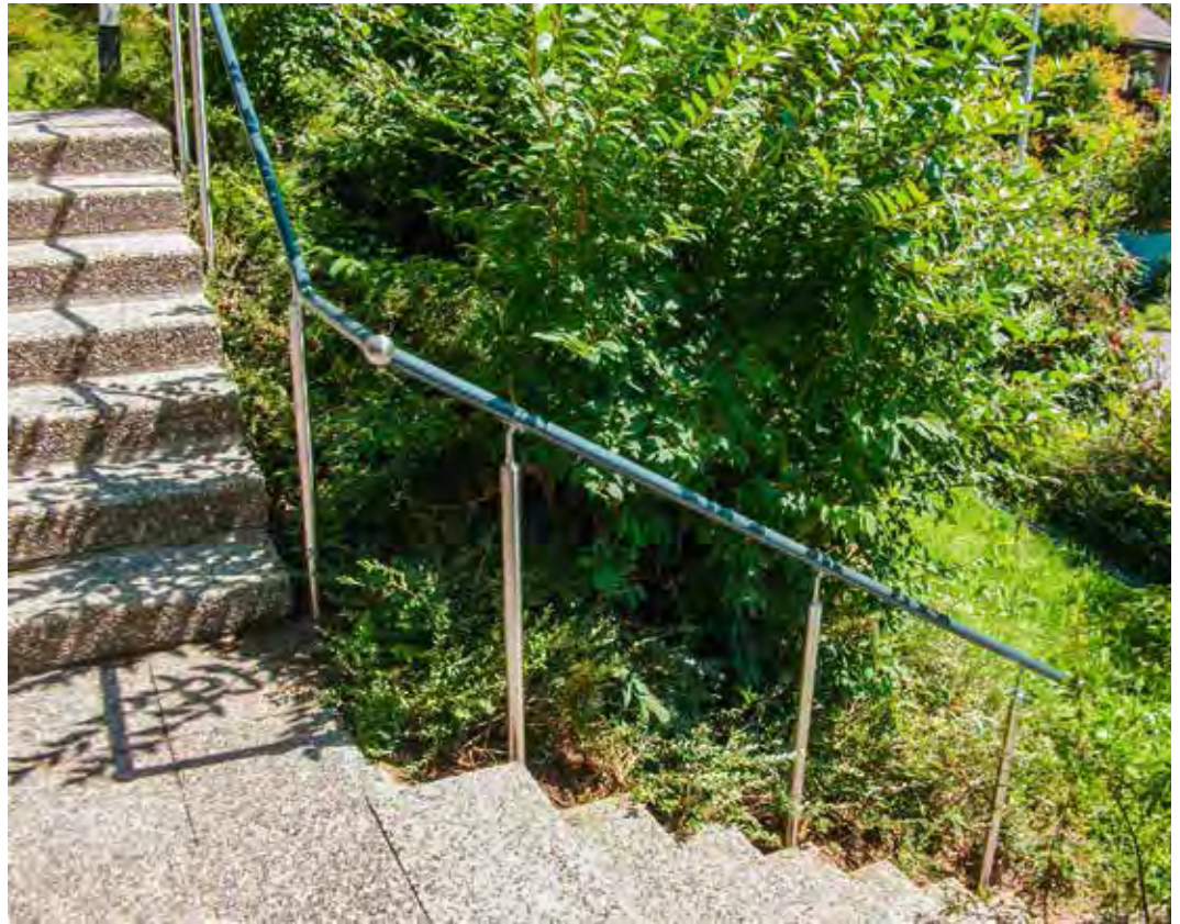
Aussenhandlauf mit einbetonierten Stützen
