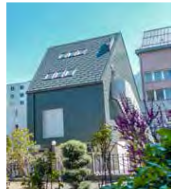
Die Elemente wurden im Werk der Casa-Vita® / Frefel Holzbau AG in Mollis vorgefertigt und bei schönem Wetter innerhalb von 2 Tagen montiert.
