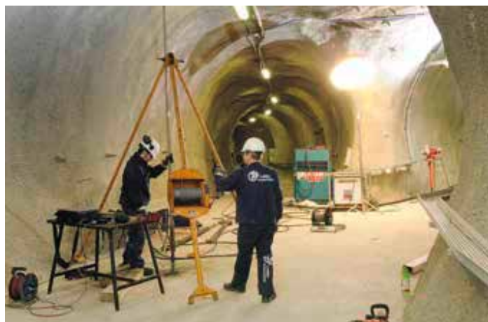
Bauarbeiten im Opalinuston: Erstellung der Galerie 08 im Felslabor Mont Terri. Bild: COMET
