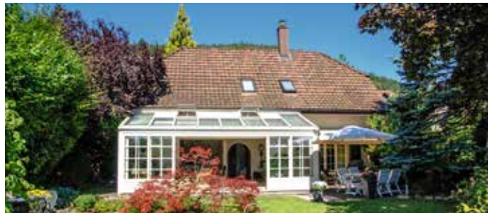
Das bald 30-jährige Einfamilienhaus mit einer Wohnfläche von total 200 m 2 steht mitten in einem idyllischen Quartier der Gemeinde Geroldswil, Kt. ZH
