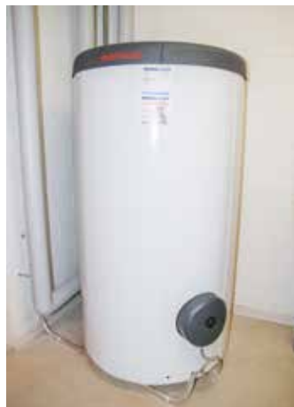
Trinkwasserspeicher mit 300 Liter Inhalt sorgt für einen hohen Warmwasserkomfort. Ein grosses Speichervolumen erlaubt angenehme Warmwassertemperaturen und hilft Energie zu sparen.
