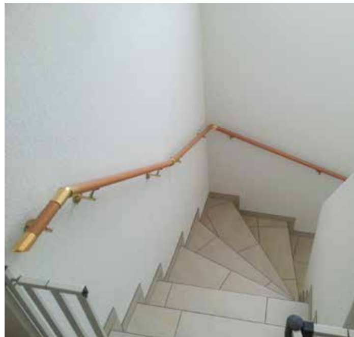
Handlauf in Buche, wandseitig, wo die Stufen breiter und damit sicherer sind
