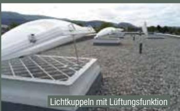
Lichtkuppeln mit Lüftungsfunktion
